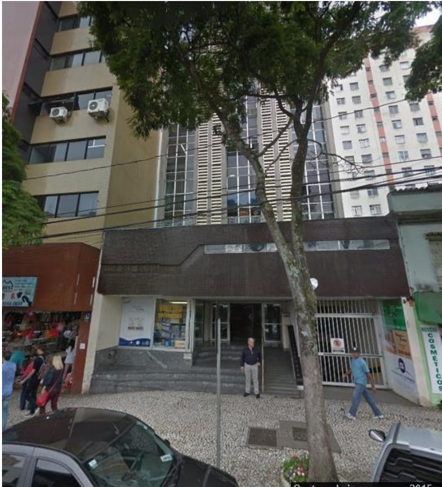
FOTO 1 – FACHADA DO PRÉDIO
