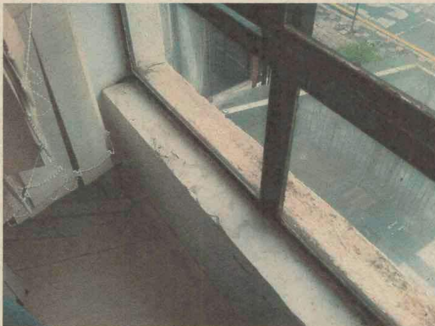
15- VISTA DE INFILTRAÇÃO PELA JANELA
