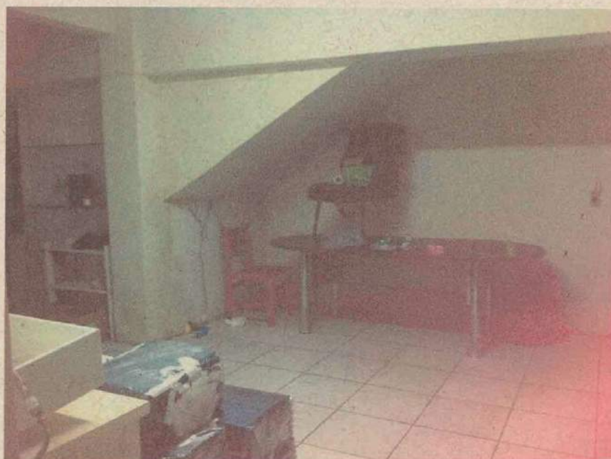
12- VISTA INTERNA DA CONSTRUÇÃO DO ESTACIONAMENTO
