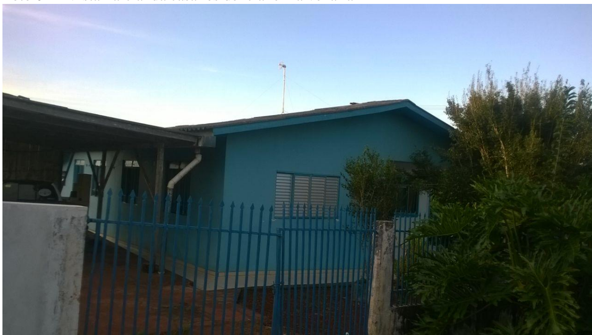
Foto 01 – Vista Parcial da casa residencial em alvenaria
