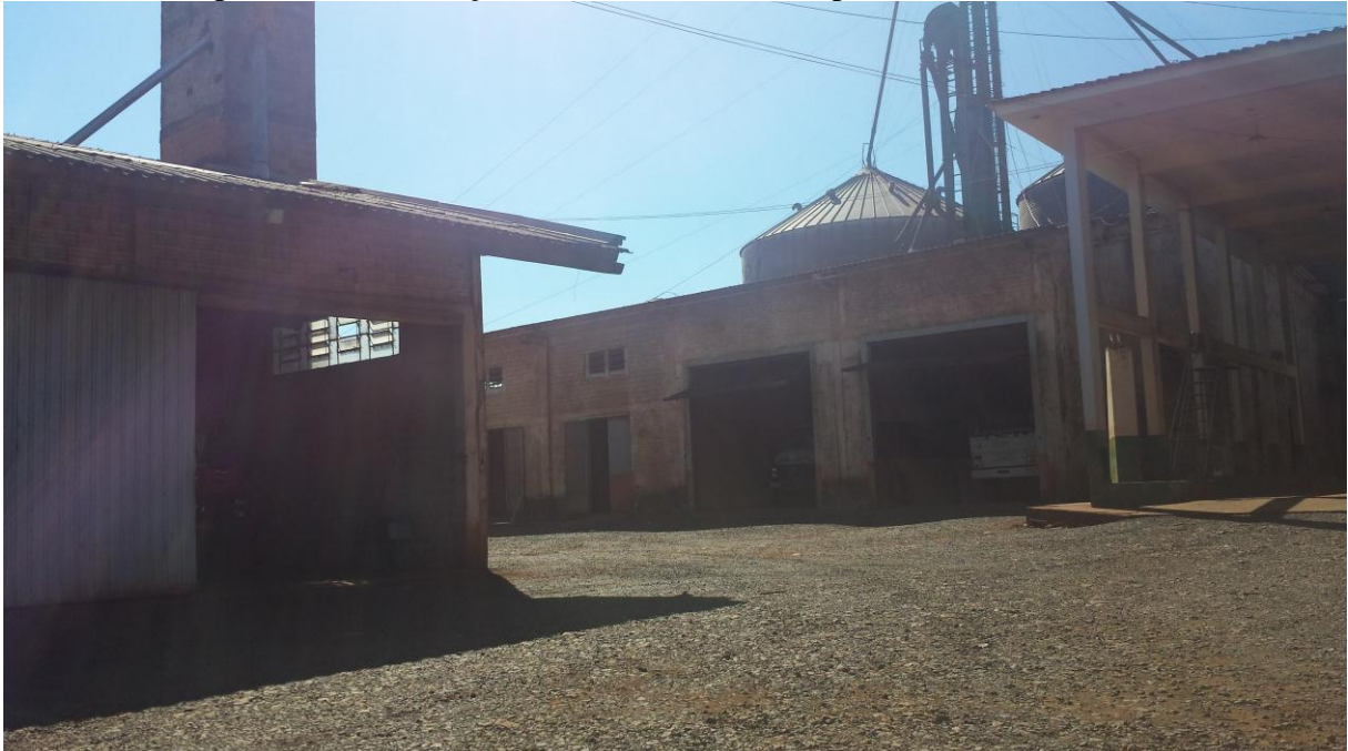
Foto 2 – Vista parcial da construção em reboco medindo aproximadamente 20x16m
