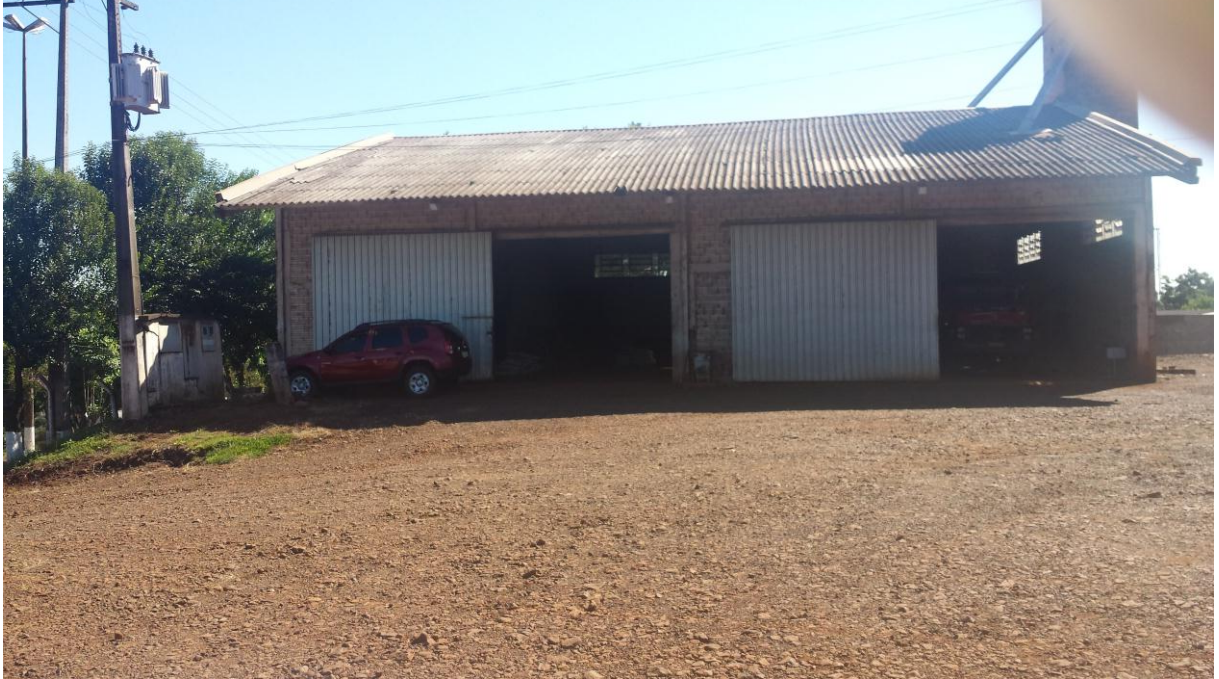
Foto 3 – Vista parcial da construção em alvenaria com reboco medindo 22x24m
