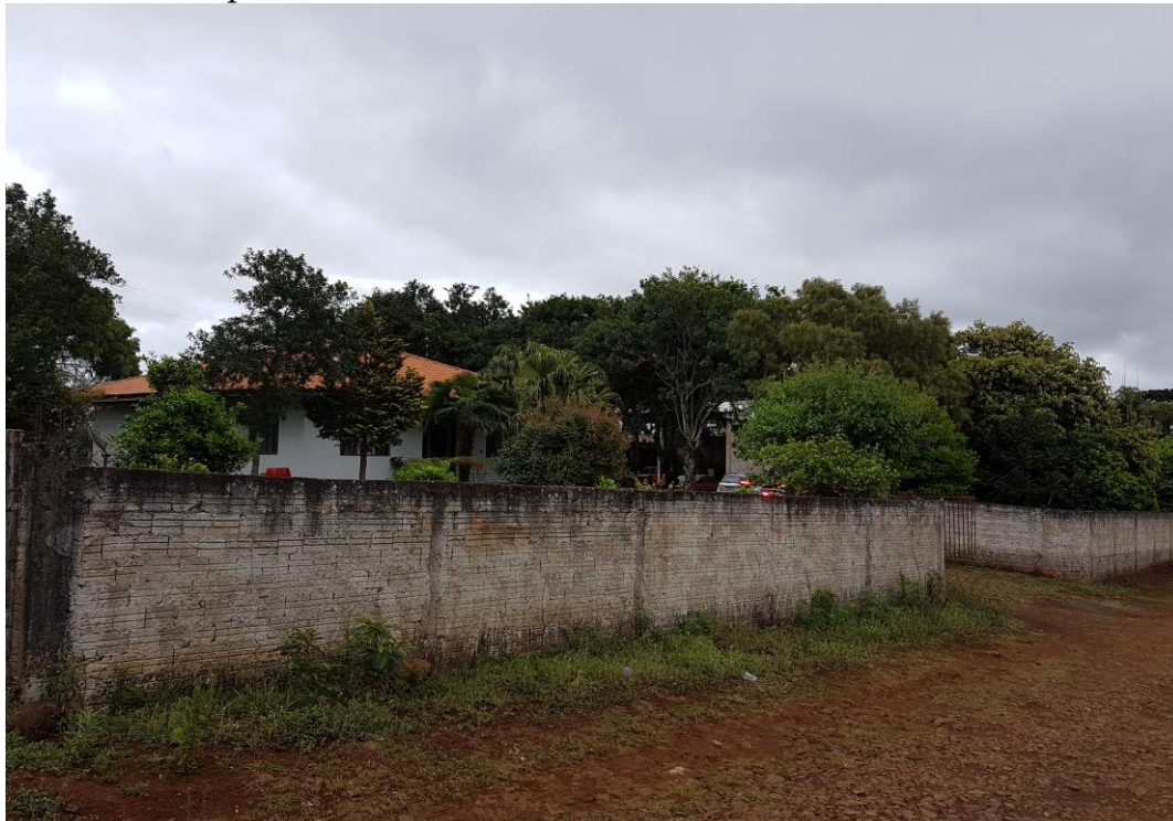
Foto 1 - Vista parcial lateral do imóvel urbano
