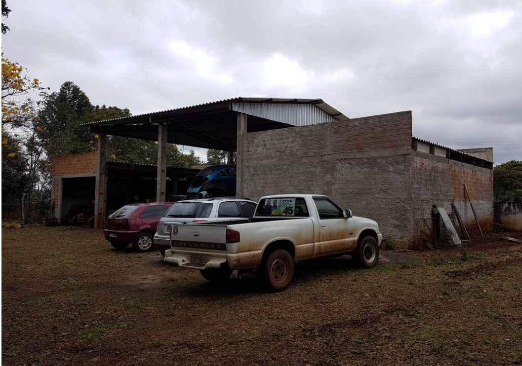
Foto 5 - Vista parcial lateral da Barracão - Oficina Mecânica
