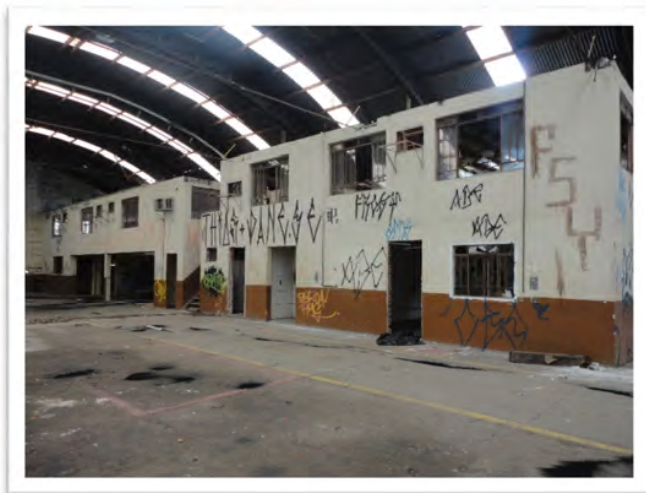
Vista do interior das edificações remanescentes.
