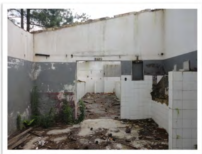
Vista do interior das edificações remanescentes.
