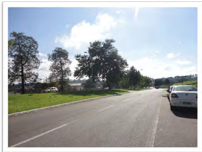
Frente do imóvel para a Estrada da Graciosa.
