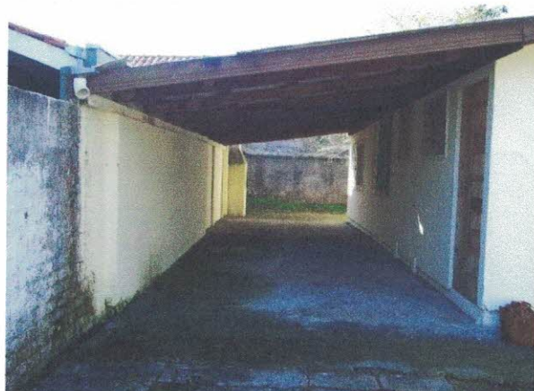
Vista da garagem
