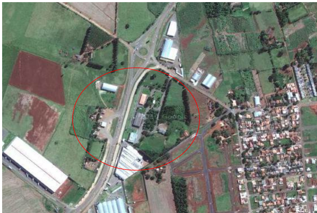
Vista aérea parcial do Imóvel
