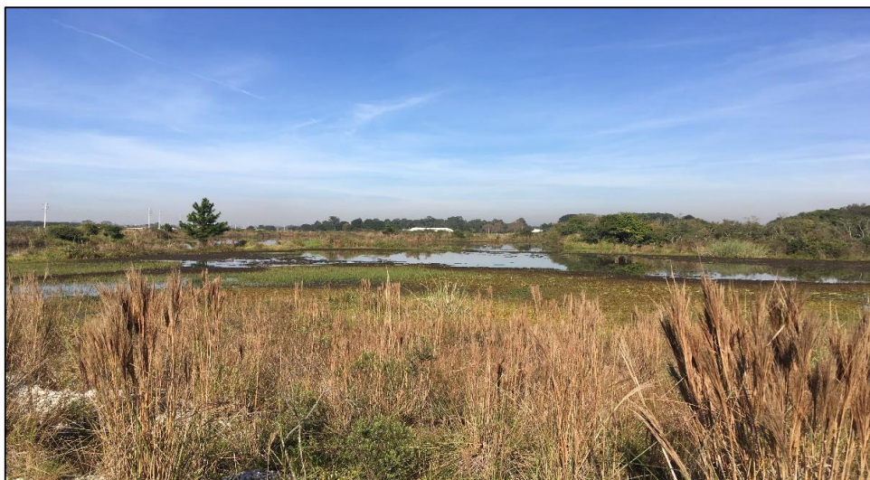
Ilustrações 7 e 8: No alto, mapa de Zoneamento da UTP do Guarituba com destaque, em vermelho, para o imóvel avaliado. Embaixo, vista parcial de sua superfície alagadiça.
