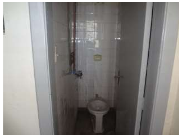
Banheiro de serviços
