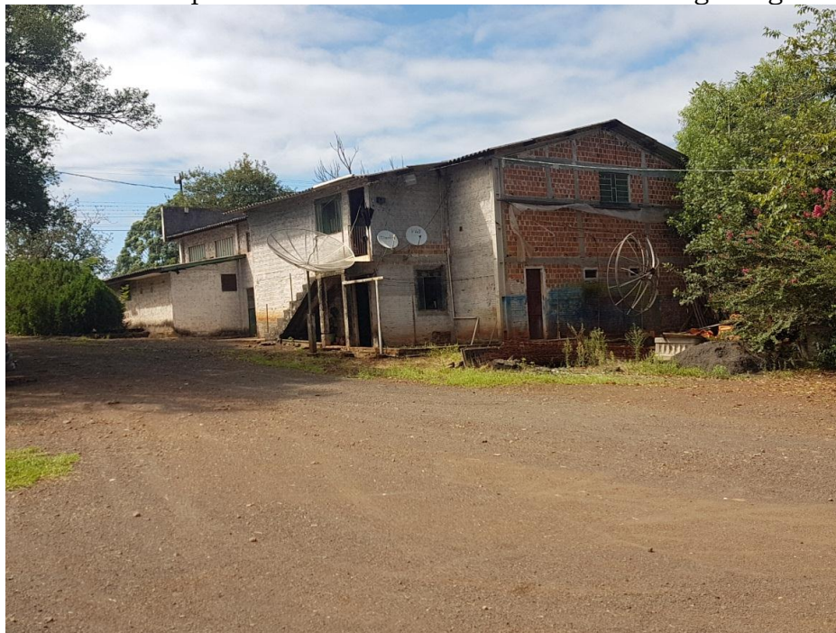
Foto 1 – Vista parcial do barracão em alvenaria – antigo Frigorífico
