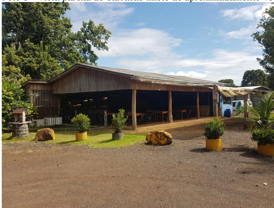
Foto 3 – Vista parcial do barracão misto de aproximadamente 400 m 2
