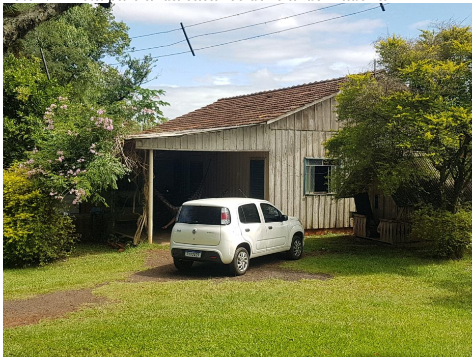
Foto 2 – Vista parcial da casa residencial de madeira
