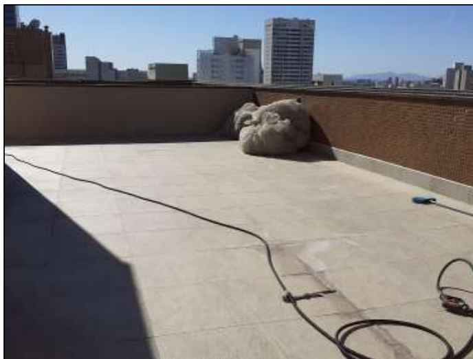
Vista geral do terraço – piso apresenta eflorescências
