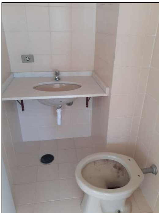
Banheiro 2 (pavimento inferior)
