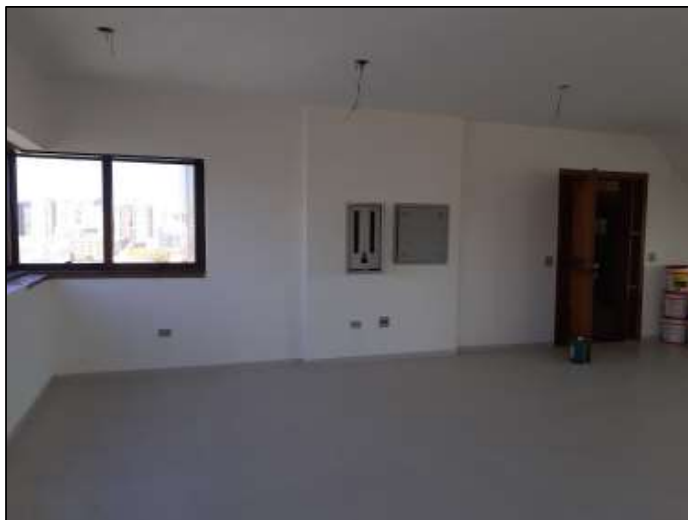
Vista geral da sala (pavimento inferior) – de outro ângulo
