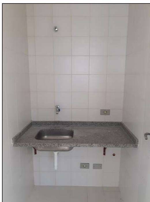
Copa/cozinha 2 (pavimento inferior)
