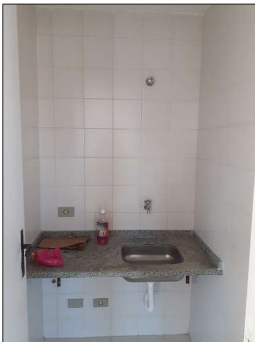
Copa/cozinha 1 (pavimento inferior)
