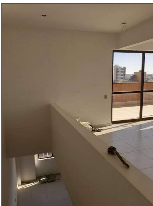
Vista geral da sala (ático)
