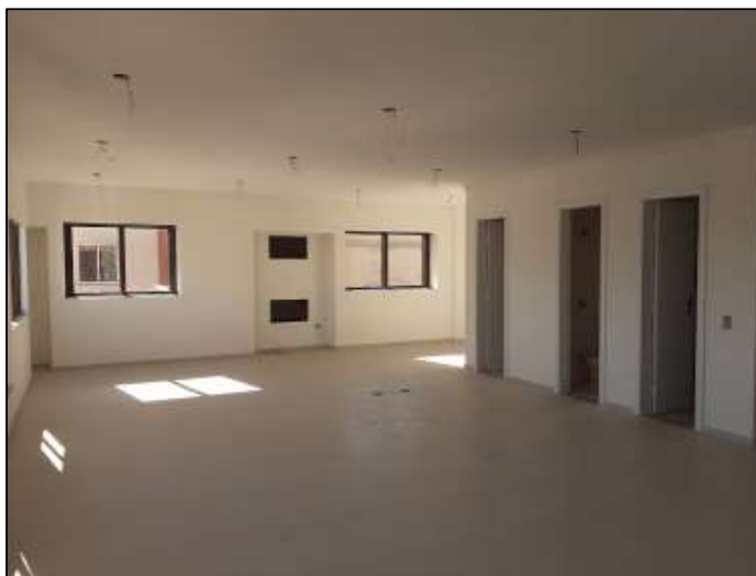
Vista geral da sala (pavimento inferior) – de outro ângulo
