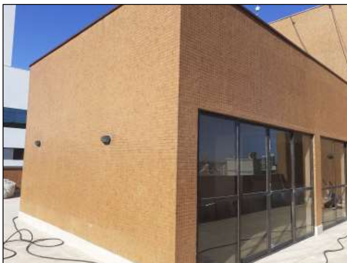
Vista parcial externa da sala localizada no ático – de outro ângulo
