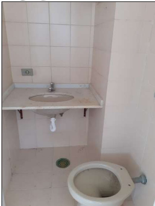
Banheiro 3 (pavimento inferior)
