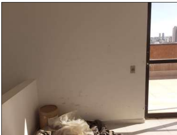
Infiltração em parede as sala (ático)
