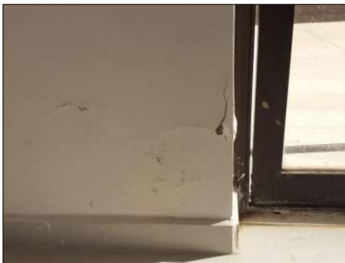
Infiltração em parede as sala (ático)
