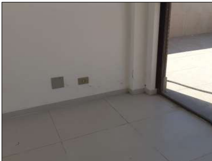
Infiltração em parede as sala (ático)
