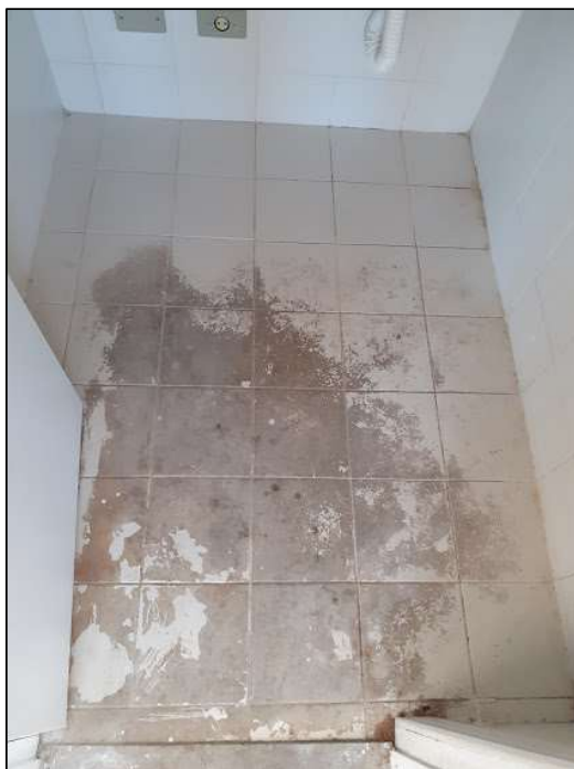
Piso da copa/cozinha 1 (pavimento inferior)
