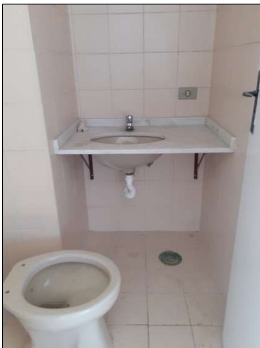
Banheiro 4 (pavimento inferior)
