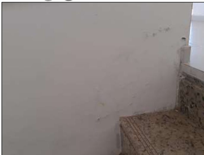
Infiltração em parede da escada que dá acesso ao ático
