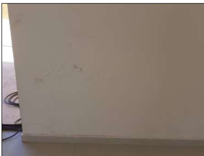
Infiltração em parede as sala (ático)
