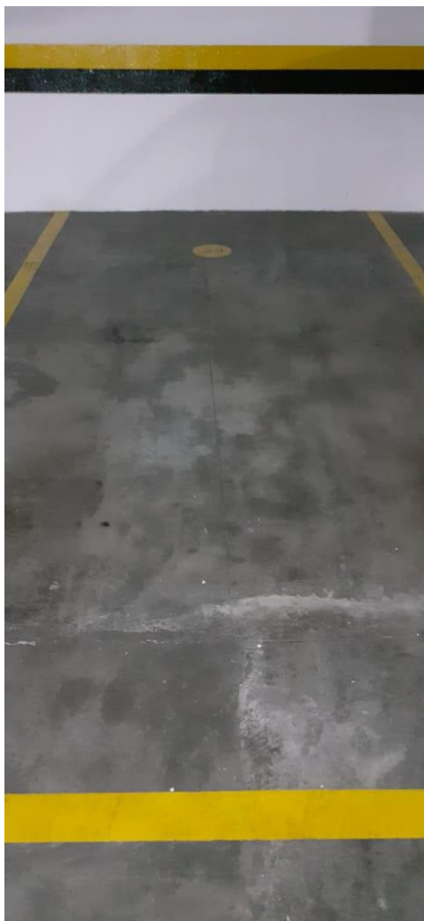
Vista da vaga nº 24 – localizada no subsolo I
