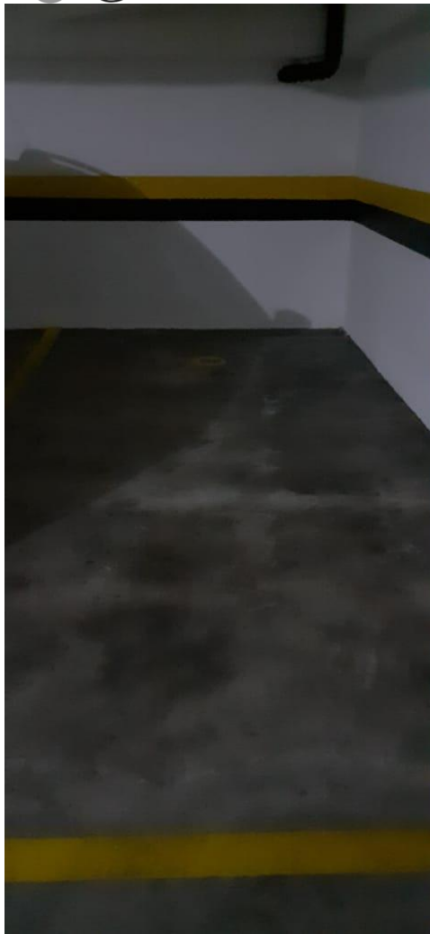
Vista da vaga nº 130 – localizada no subsolo III
