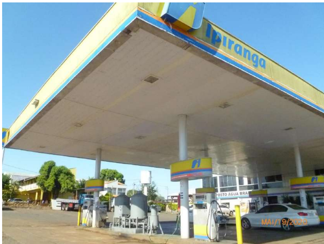
Figura 4 – Vista da área da cobertura das ilhas de abastecimento e que integra o Imóvel Objeto.
