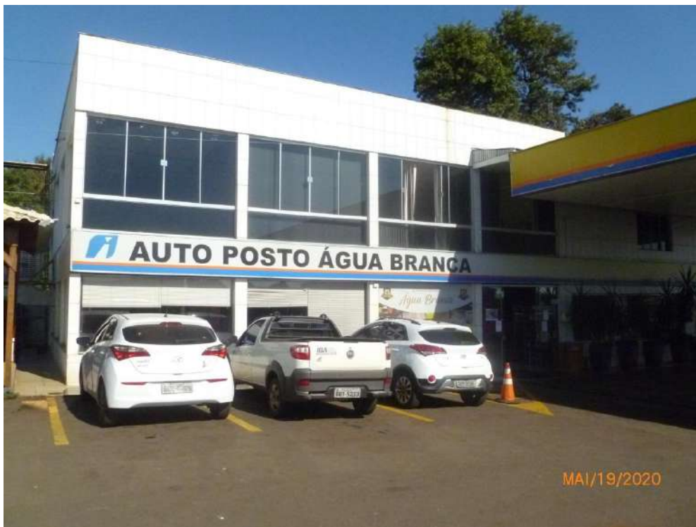
Figura 5 – Vista parcial da edificação em dois pavimentos e ocupada com restaurante, área de recepção/administrativa do posto, depósitos, sanitários e salas comerciais.
