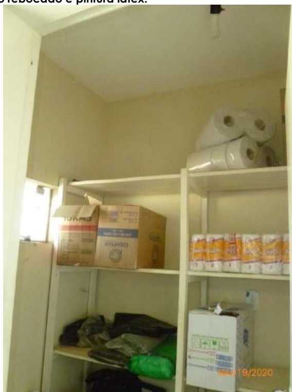
Figura 41 – Pavimento térreo - Vista parcial do depósito 2, com paredes rebocadas e pintura látex e piso em cerâmica. Teto rebocado e pintura látex.
