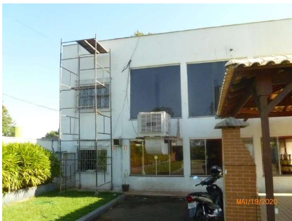
Figura 23 – Vista parcial da fachada lateral esquerda do prédio de 2 pavimentos com parede revestida com reboco feltrado e pintura em látex. Parte das janelas em vidro temperado e perfis de apoio em alumínio e parte com janelas de correr – esquadria metálica para a área da cozinha e de sala do pavimento superior.
