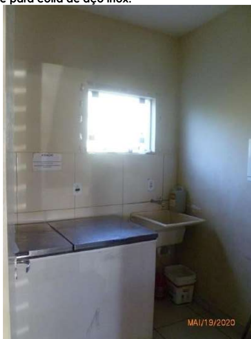
Figura 39 – Pavimento térreo - Vista parcial da área de serviço/despensa de apoio à cozinha do restaurante. Uma parede revestida com azulejos até meia altura e o restante, inclusive demais paredes, revestidas com reboco feltrado e pintura látex. Piso em cerâmica.
