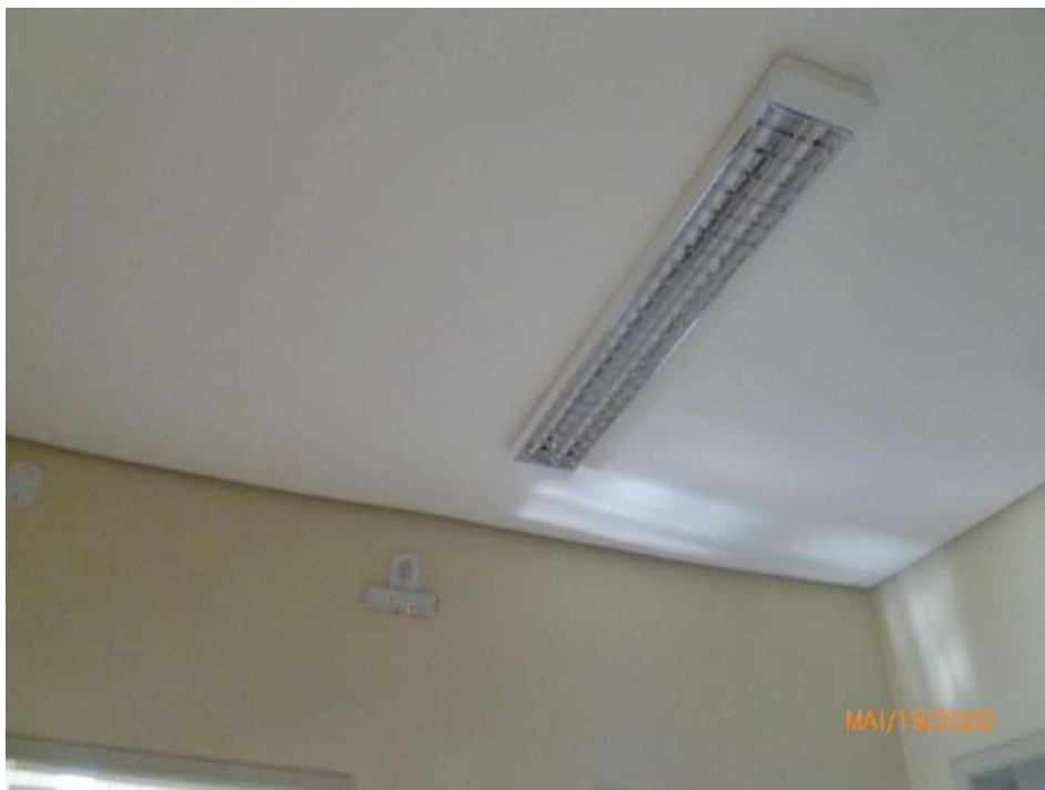
Figura 55 – Pavimento superior - Vista parcial do Hall de distribuição com destaque para o forro em gesso liso com pintura em látex, assim como as paredes rebocadas.
