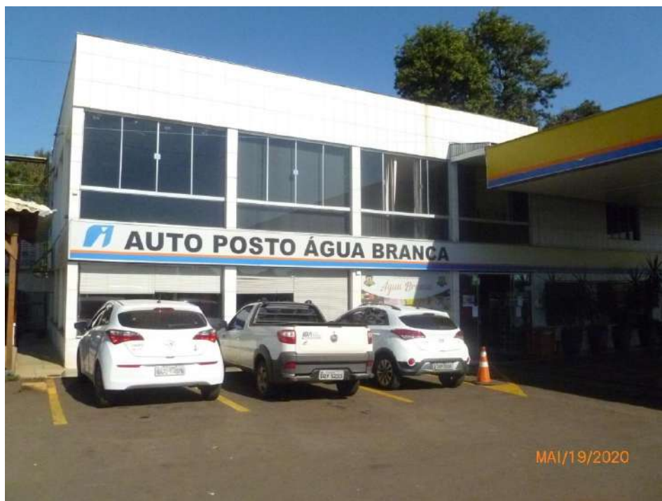
Figura 22 – Vista parcial da fachada principal do prédio de 2 pavimentos com parede revestida com reboco feltrado e pintura em látex. Destaque para as janelas em vidro temperado e perfis de apoio em alumínio.
