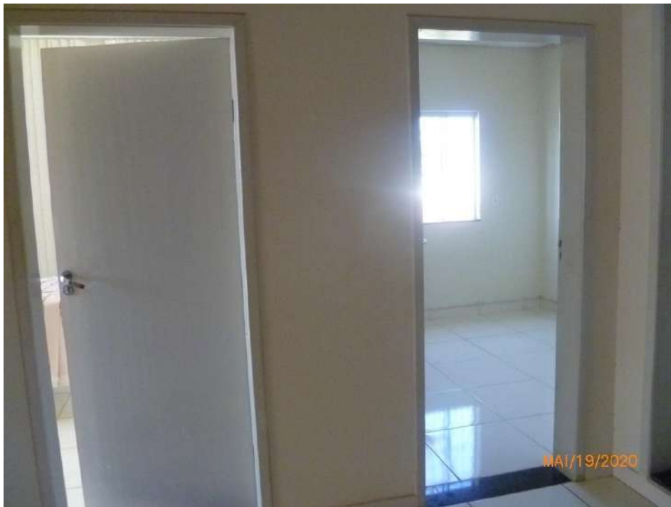
Figura 54 – Pavimento superior - Vista parcial do Hall de distribuição com destaque para portas de entrada das Salas 2 (direita) e 3 (esquerda).
