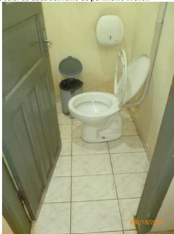
Figura 47 – Pavimento superior - Vista parcial do WC entre o Depósito e a Sala 4 (indicação figura 10). Paredes rebocadas e com pintura látex. Piso revestido com cerâmica. Louça sanitária com caixa de descarga. Porta de madeira.
