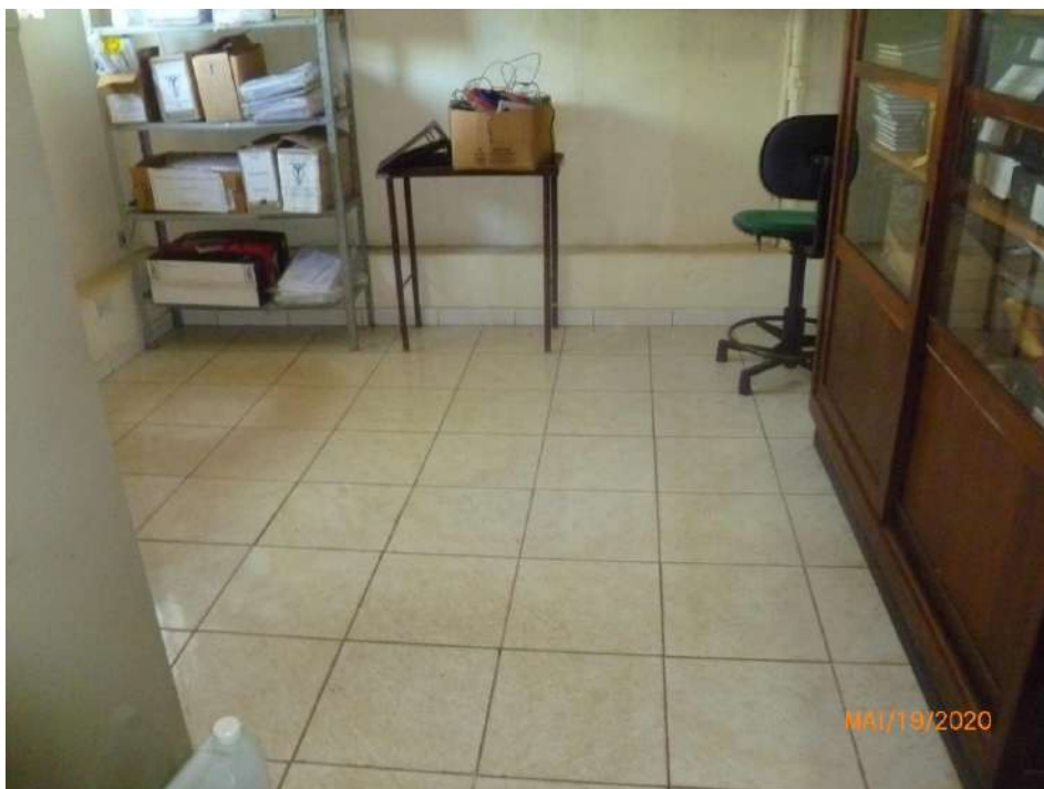
Figura 45 – Pavimento superior - Vista parcial do Depósito anexo a Sala 4 (indicação figura 11). Piso e rodapé em cerâmica. Paredes rebocados e pintura látex.
