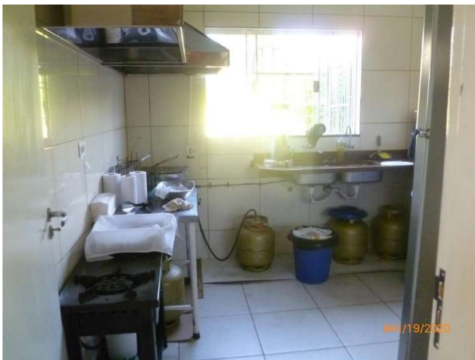
Figura 37 – Pavimento térreo - Vista parcial da cozinha com as paredes revestidas com azulejo e piso em cerâmica.
