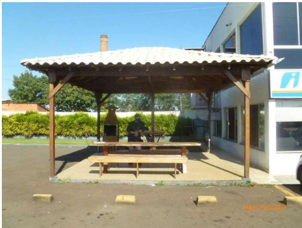
Figura 6 – Visualização de área anexa – “churrasqueira” – edificada ao lado do prédio em dois pavimentos.
