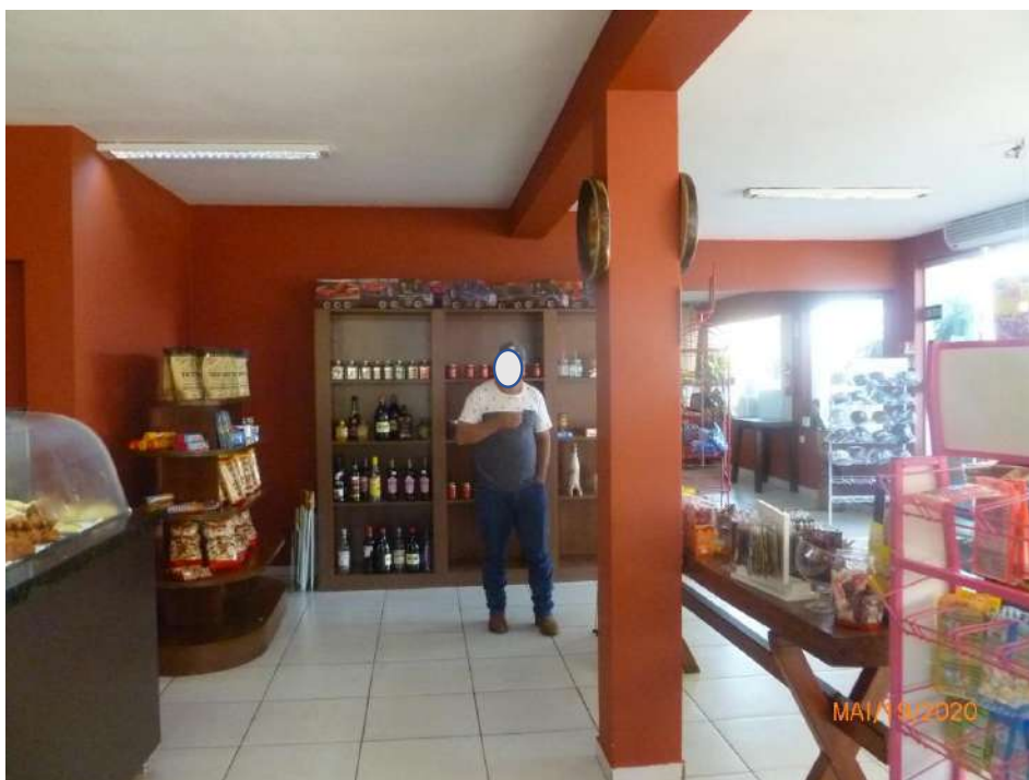
Figura 33 – Pavimento térreo - Vista parcial interna da área de atendimento ao público do restaurante/lanchonete e setor de conveniências. Destaque para paredes e tetos com revestimento em reboco feltrado e pintura látex. Piso revestido com cerâmica.
