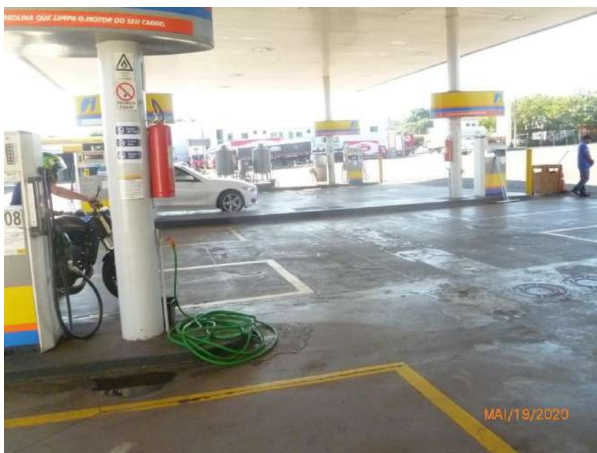
Figura 13 – Vista parcial da área de piso do setor de abastecimentos executado em concreto polido em regular estado de conservação. Visualização das ilhas – local da instalação das bombas – em nível superior ao do piso.
