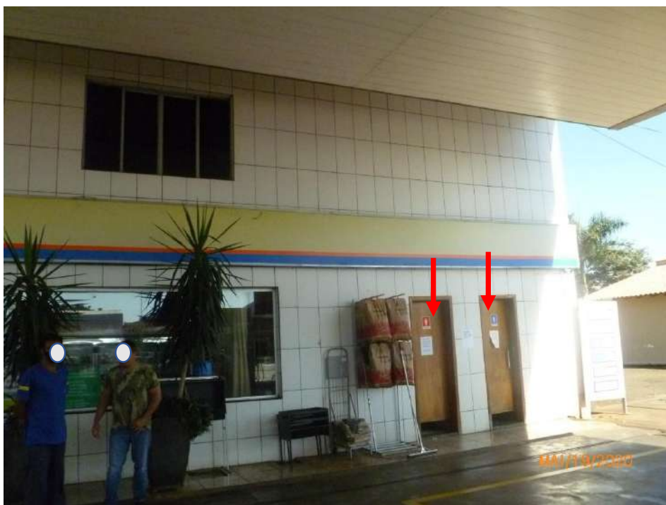
Figura 21 – Vista parcial da fachada principal do prédio de 2 pavimentos com parede revestida com cerâmica retangular. Destaque para as entradas - portas - dos sanitários de apoio a área de abastecimento (indicação pelas setas em vermelho).
