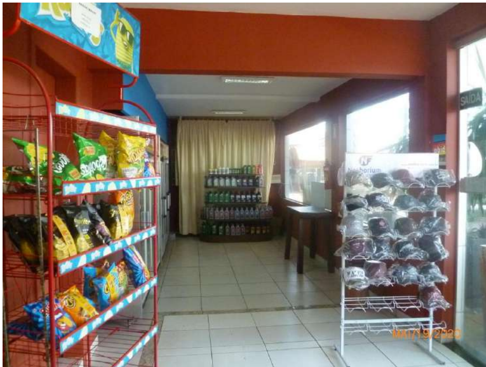
Figura 36 – Pavimento térreo - Vista parcial interna da área de vendas de bebidas (indicação na figura 9) e de apoio ao restaurante. Piso em cerâmica, paredes e tetos rebocados e pintura látex.
