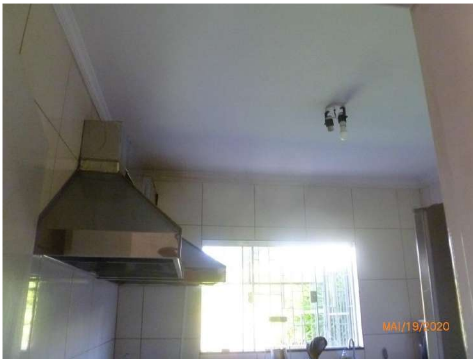
Figura 38 – Pavimento térreo - Vista parcial do teto da cozinha com a laje revestida e pintura látex e sanca de gesso. Destaque para coifa de aço inox.
