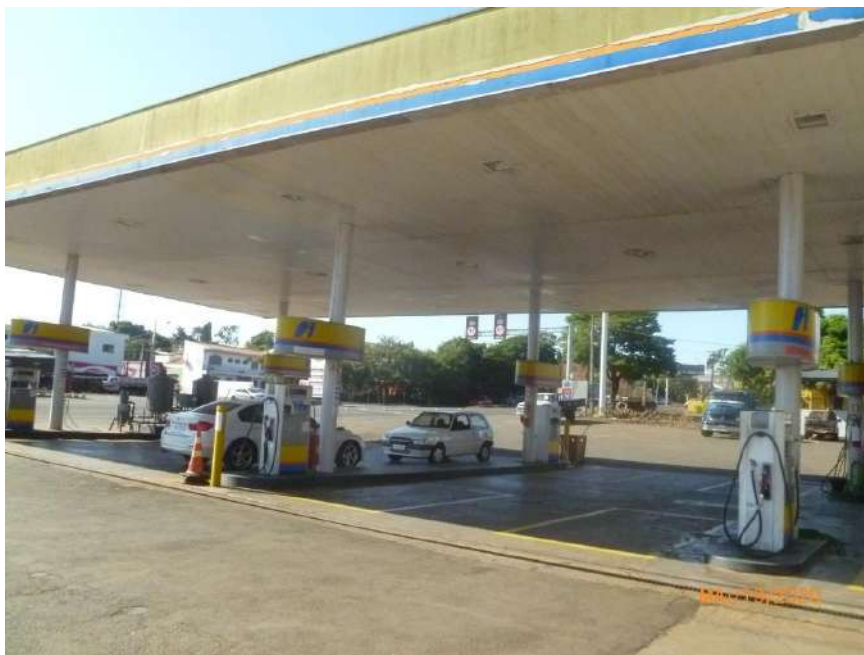
Figura 12 – Vista parcial da área de abastecimento sob cobertura com estrutura metálica, piso em concreto polido com captação de águas incidentes do piso através de canaletas metálicas instaladas no perímetro da área. Visualização das colunas metálicas de sustentação da estrutura de cobertura.
