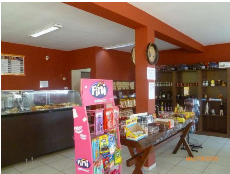
Figura 32 – Pavimento térreo - Vista parcial interna da área de atendimento ao público do restaurante/lanchonete. Destaque para paredes e tetos com revestimento em reboco feltrado e pintura látex. Piso revestido com cerâmica.
