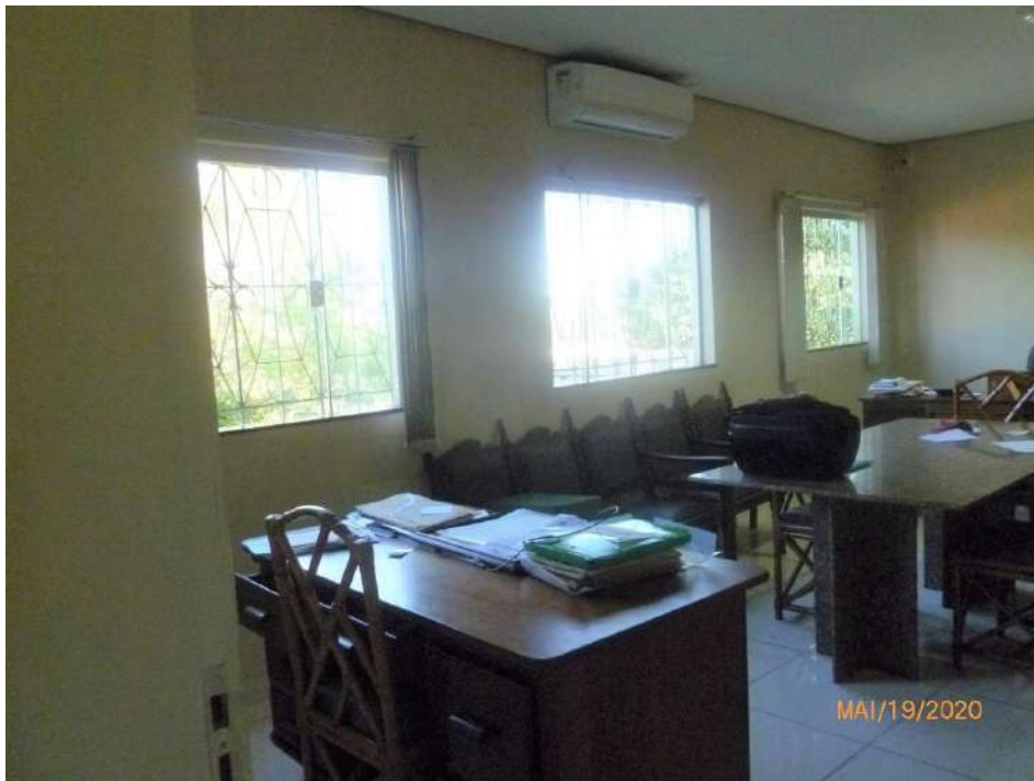
Figura 56 – Pavimento superior - Vista parcial do Escritório, com teto revestido com gesso liso e pintura em látex, piso revestido com cerâmica, esquadrias metálicas, paredes rebocadas e pintura látex.
