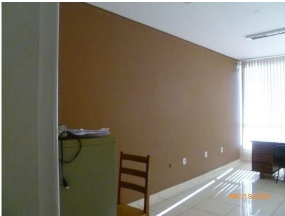
Figura 59 – Pavimento superior - Vista parcial da Sala 1, com destaque para piso revestido com cerâmica, paredes rebocadas com pintura em látex e forro de gesso liso com pintura.
