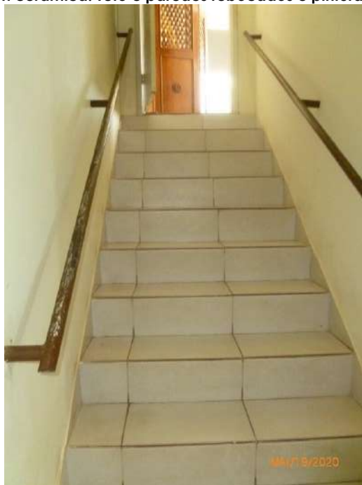
Figura 43 – Pavimento térreo - Vista parcial do segundo trecho da escada de acesso ao pavimento superior. Piso e rodapé em cerâmica. Teto e paredes rebocados e pintura látex. Corrimão em tubo metálico.
