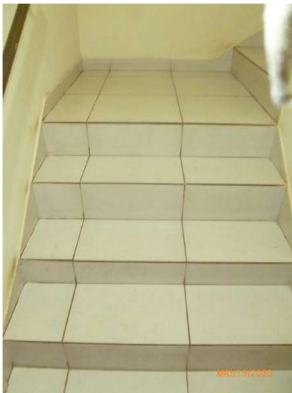
Figura 42 – Pavimento térreo - Vista parcial do primeiro trecho da escada de acesso ao pavimento superior. Piso e rodapé em cerâmica. Teto e paredes rebocados e pintura látex.
