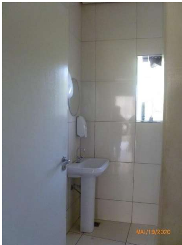
Figura 57 – Pavimento superior - Vista parcial do Banheiro, com teto revestido com gesso liso e pintura em látex, piso e paredes revestidos com cerâmica, esquadrias metálicas.
