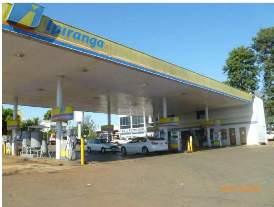
Figura 16 – Vista parcial da área de cobertura das ilhas, ao fundo do prédio em dois pavimentos, com destaque para o piso com capeamento asfáltico aplicado sobre a área com paralelepípedos.
