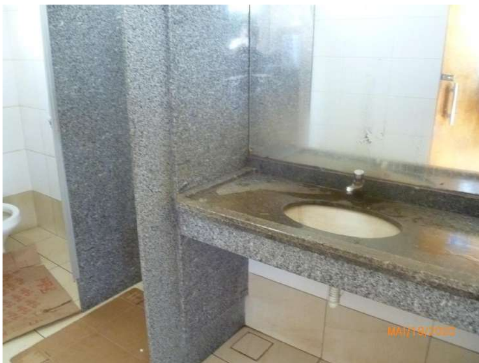
Figura 29 – Pavimento térreo - Vista interna do sanitário de apoio à área de abastecimento, com destaque para bancada de lavatório em granito e cuba de louça branca.
