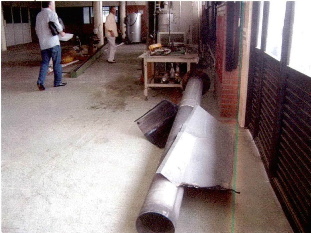
04- Vista parcial Forno desmontado
