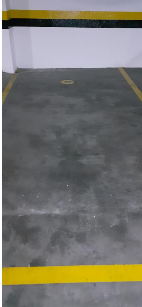
Vista da vaga nº 22 – localizada no subsolo I
