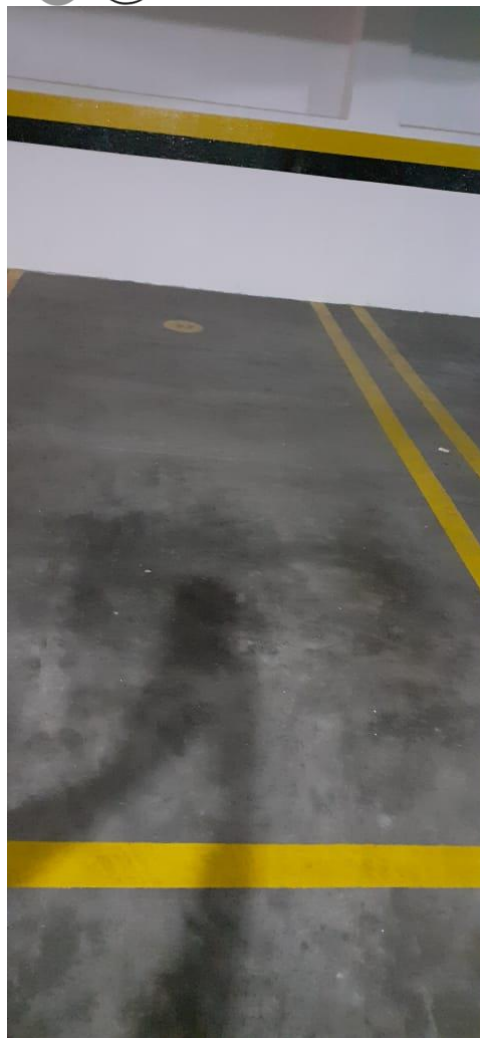
Vista da vaga nº 27 – localizada no subsolo I
