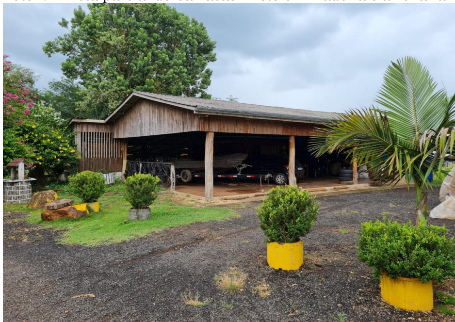
Foto 2 – Vista parcial do barracão misto em madeira e alvenaria
