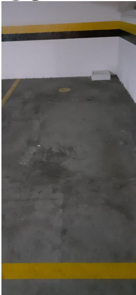
Vista da vaga nº 37 – localizada no subsolo I
