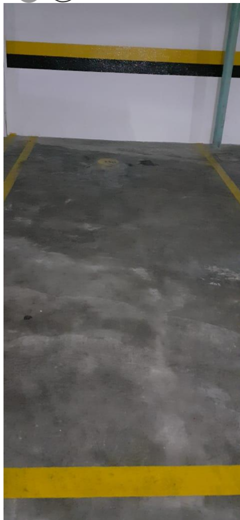
Vista da vaga nº 110 – localizada no subsolo III
