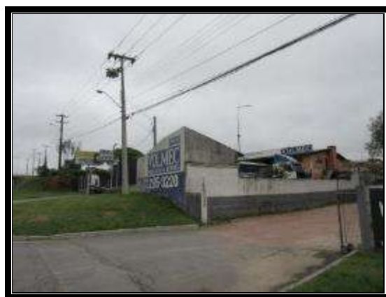
Muro – Lateral Direita.
