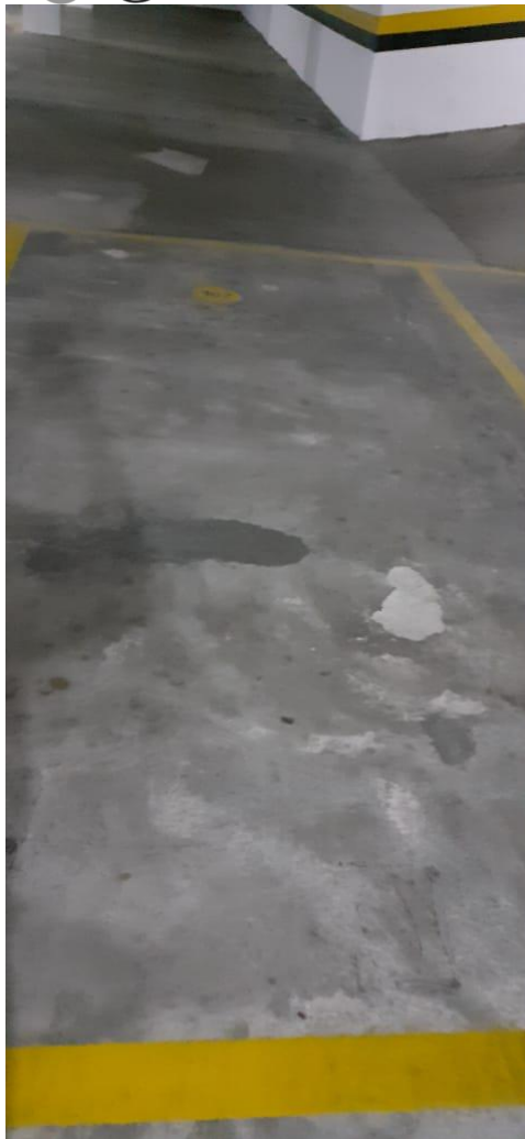
Vista da vaga nº 107 – localizada no subsolo III
