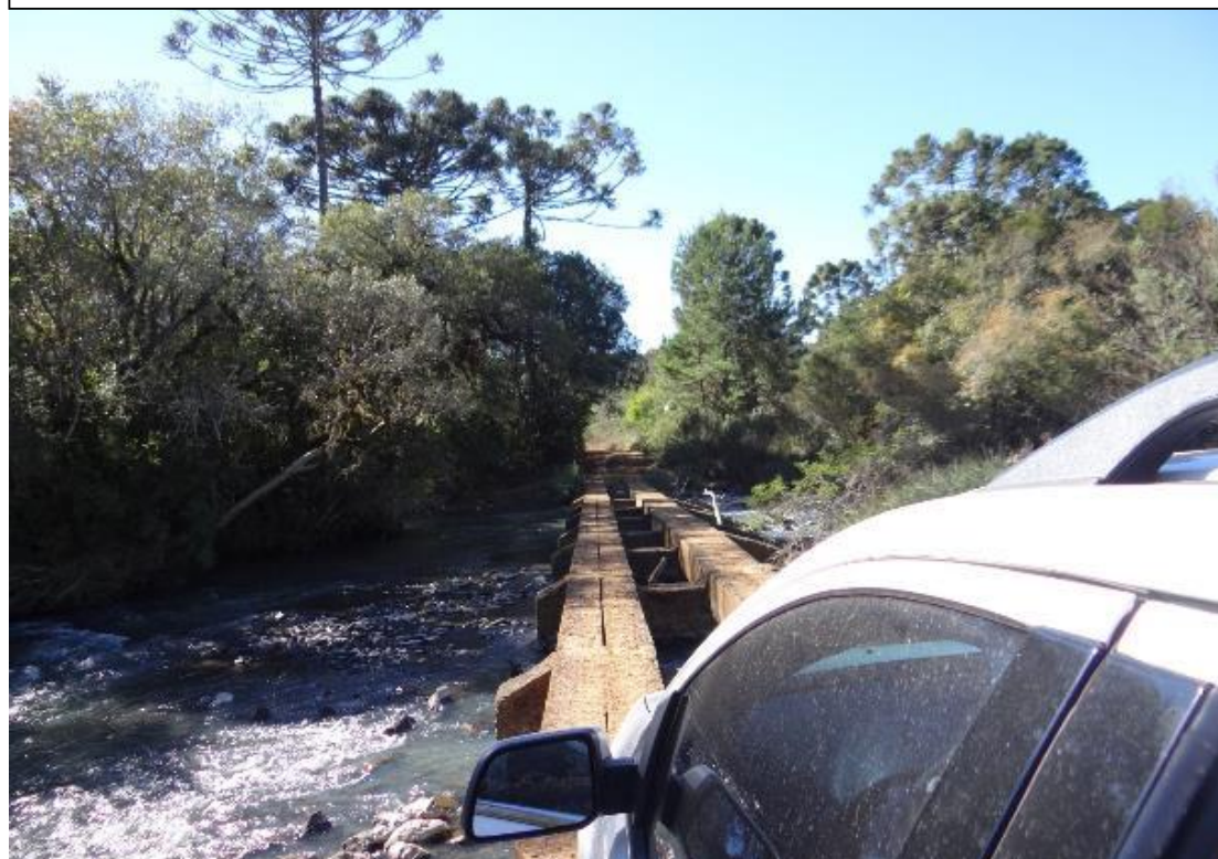
Imagem 31 – Ponte sobre o rim Iratim, dentro da propriedade
