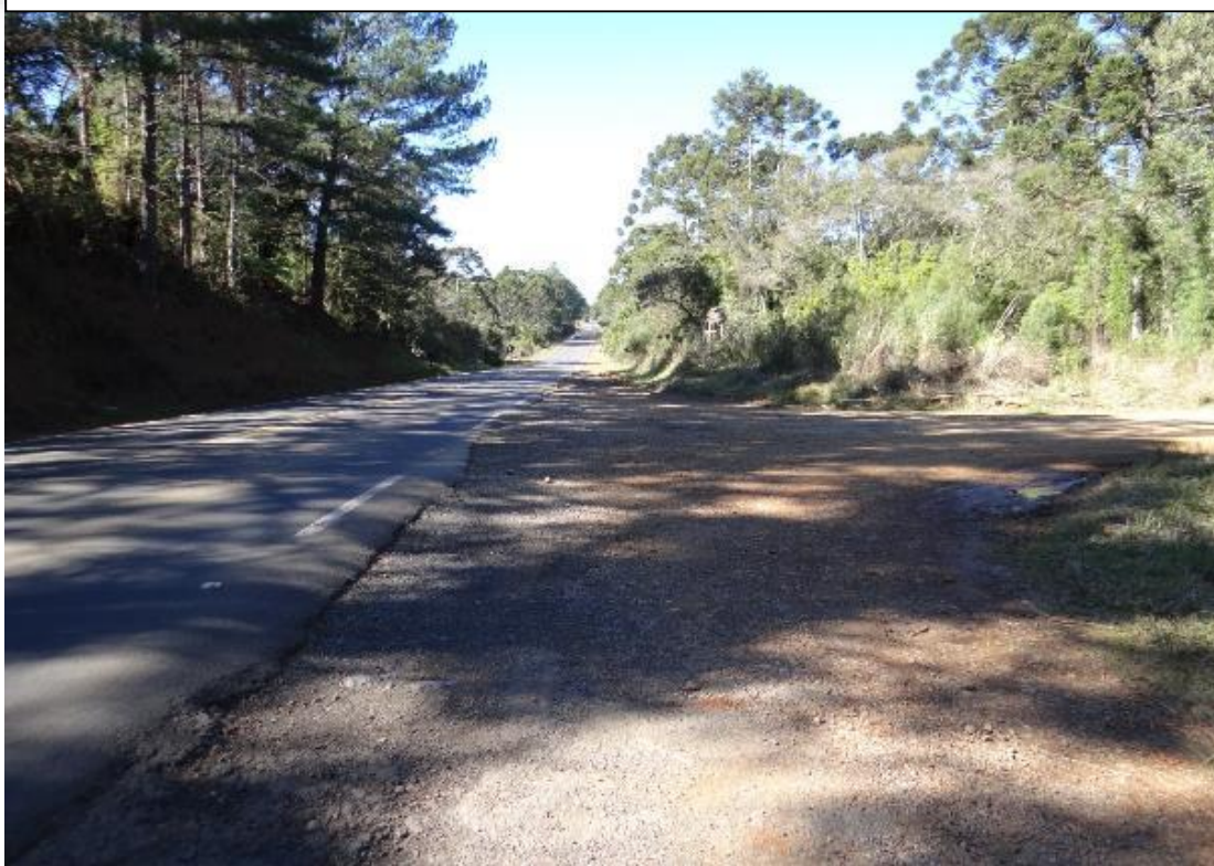
Imagem 02 - Acesso pela Rodovia Eng. Tancredo Benghi
