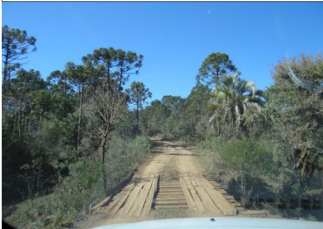
Imagem 04 – Ponte no acesso de estrada de chão
