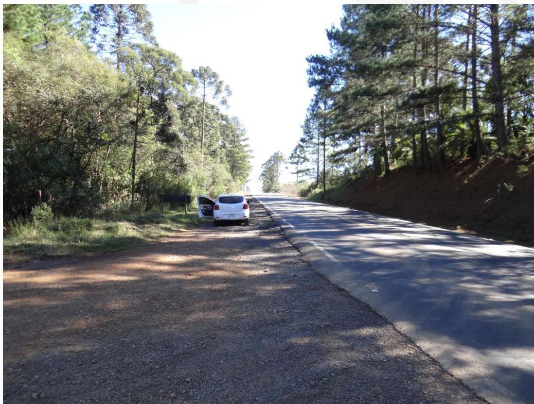
Imagem 01 - Acesso pela Rodovia Eng. Tancredo Benghi
