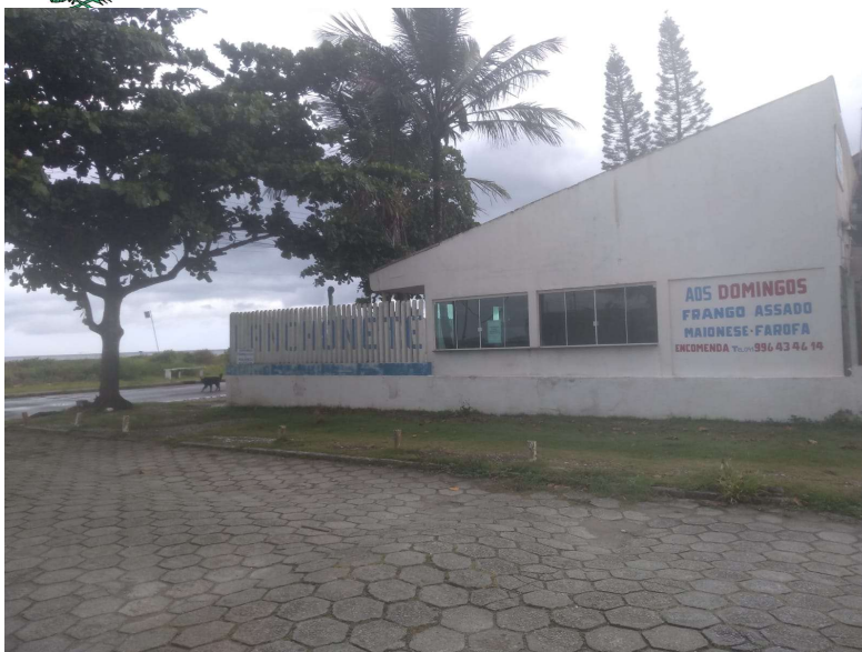
Figura 2 Vista pela Rua Padre Osvaldo Gomes
