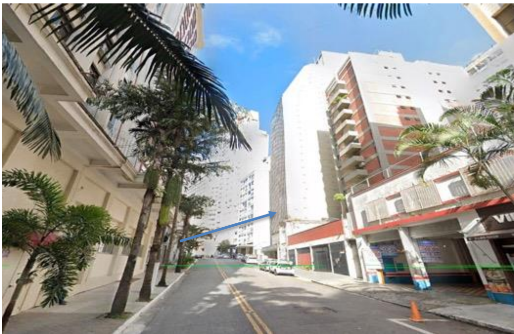
Fotos 3 e 4: Vista do Edifício GAXT (frente para Rua Álvaro de Carvalho)
