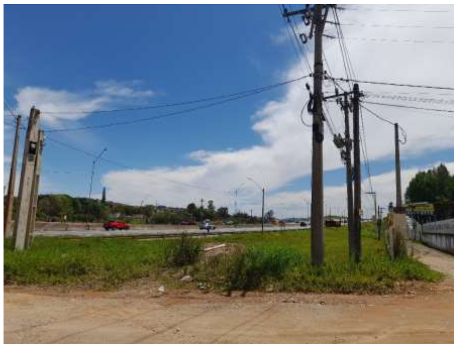
FOTO 1 – Vista da Rodovia Fernão Dias, no trecho onde se localiza a Estrada Estadual Masakasu Hayashida.
