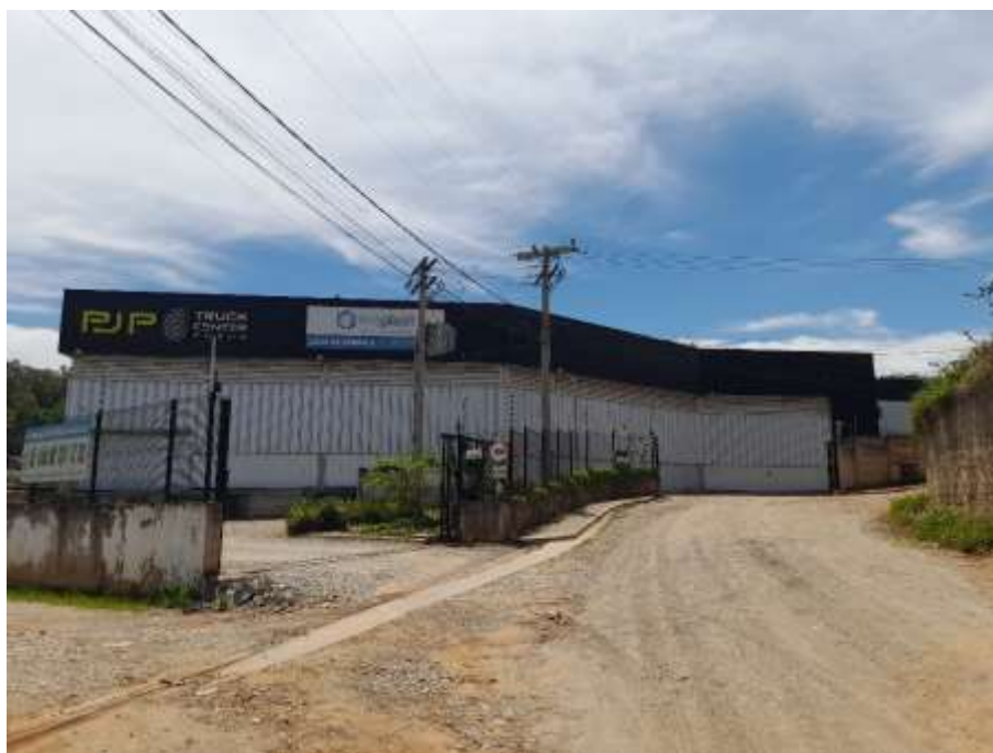
FOTO 3 – Vista da Estrada Estadual Masakasu Hayashida, onde se localiza o imóvel em questão.
