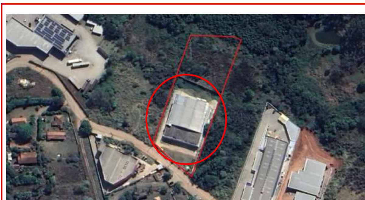
Figura 11 – Vista geral da área objeto da presente ação, com destaque para a construção existente.
