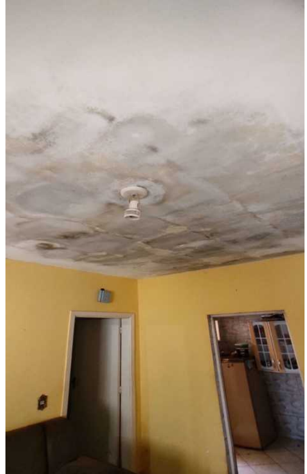
Foto 4: Sala de Estar em Piso Ceramico, Laje e Pintura Latex e sinais de Vazamento no Telhado.
