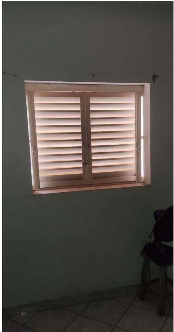
Foto 8: Domitórios 2 em Piso ceramico, Laje premoldada concreto e Pintura Latex
