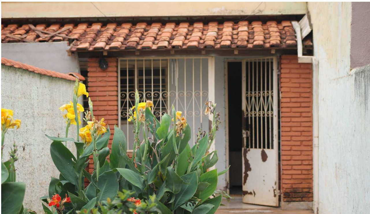
Foto 02: Entrada do Imóvel com portão de ferro e alvenaria de tijolo a vista
