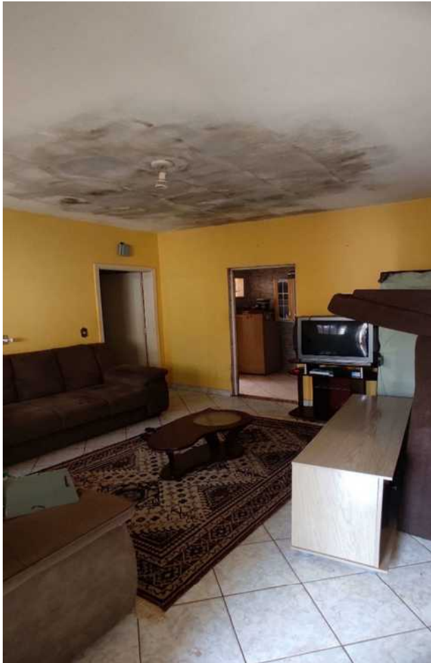
Foto 4: Sala de Estar em Piso Ceramico, Laje e Pintura Latex e sinais de Vazamento no Telhado.
