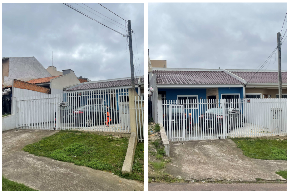
Foto 03 e 04: Vista frontal do imóvel em estudo.
