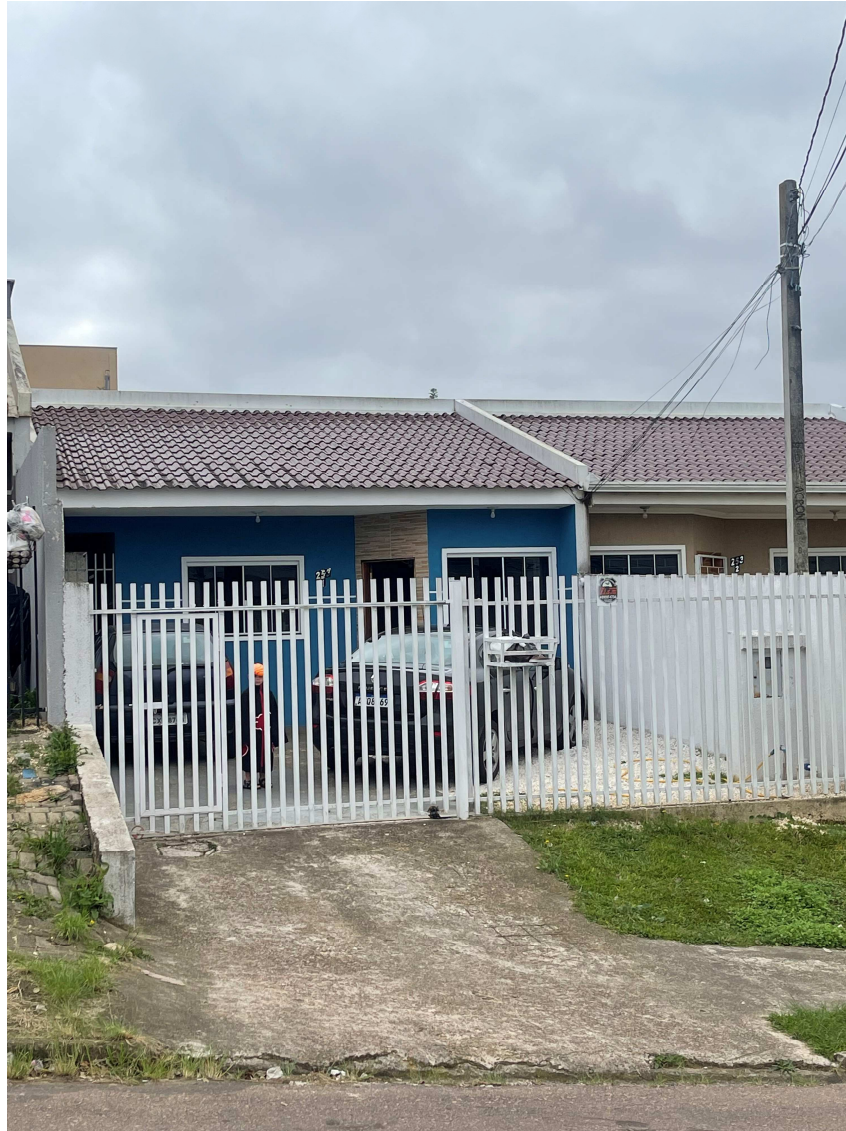
Imagem 02: Vista frontal do imóvel.
