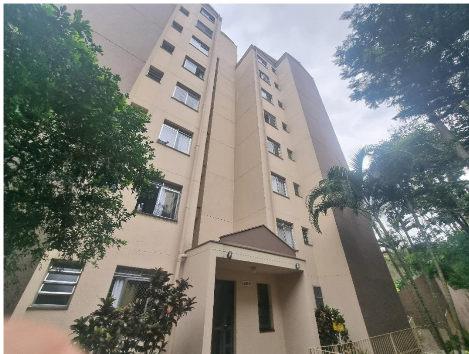
FOTO 1 – ENTRADA DO BLOCO DO I.A
