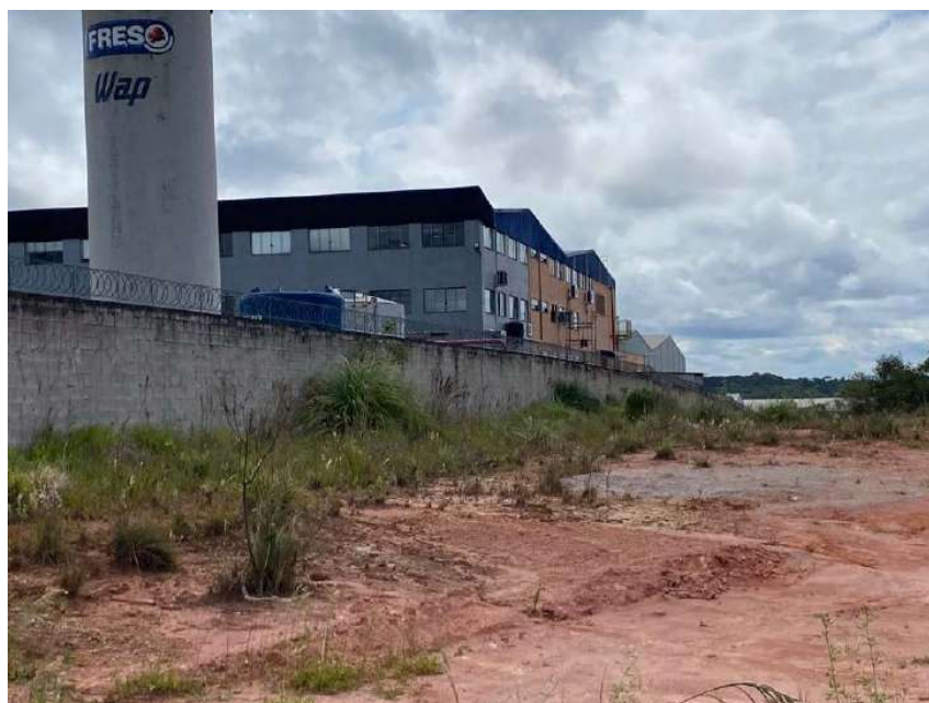
Foto 02- Fonte: Vista da lateral esquerda do imóvel. O autor (2021).
