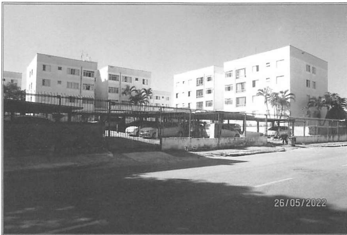
Foto nº 03: Vista geral do Condomínio Edifício Subtenente Paulo Diego, onde se localiza o Bloco M1 e respectivo apartamento avaliando.
