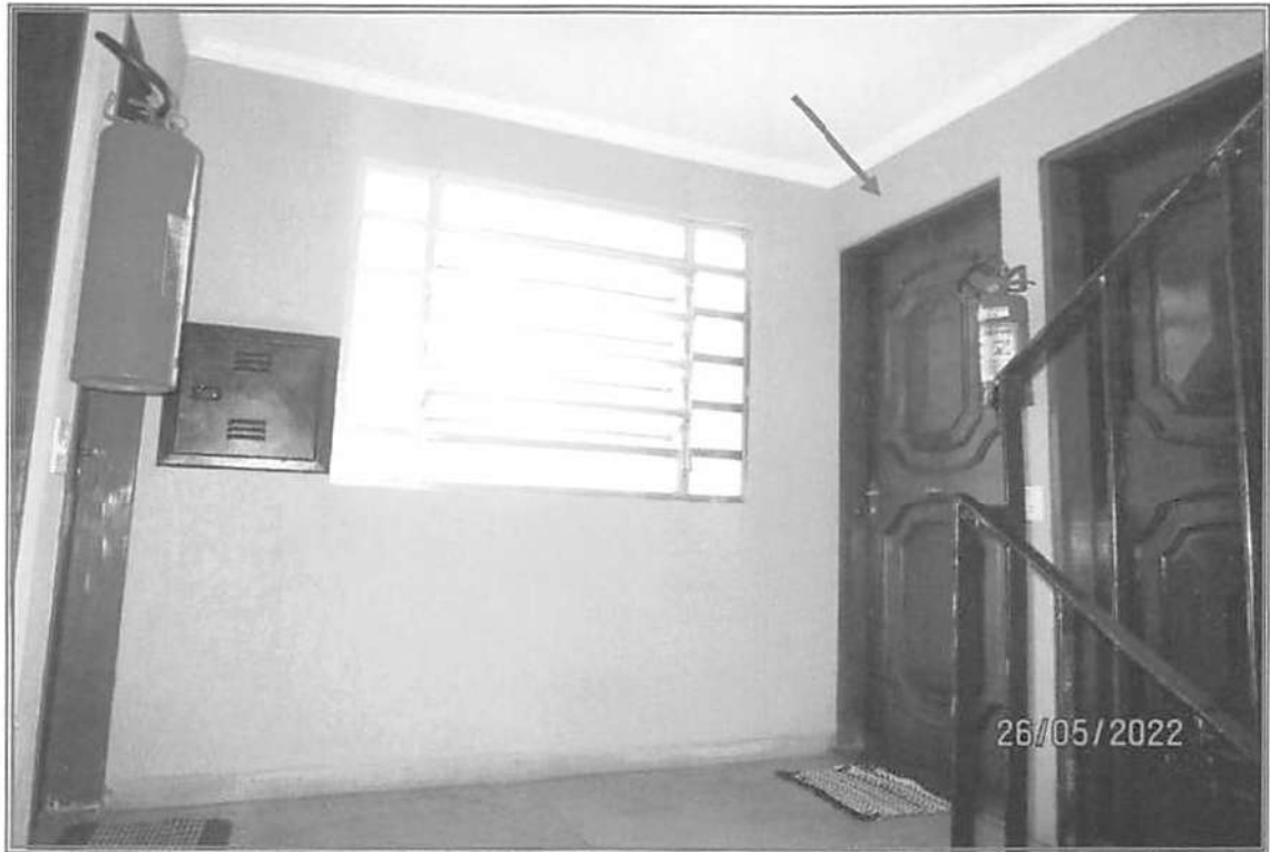
Foto nº 13: Vista geral do hall de circulação do 3º andar, onde se localiza o apartamento nº 31.
