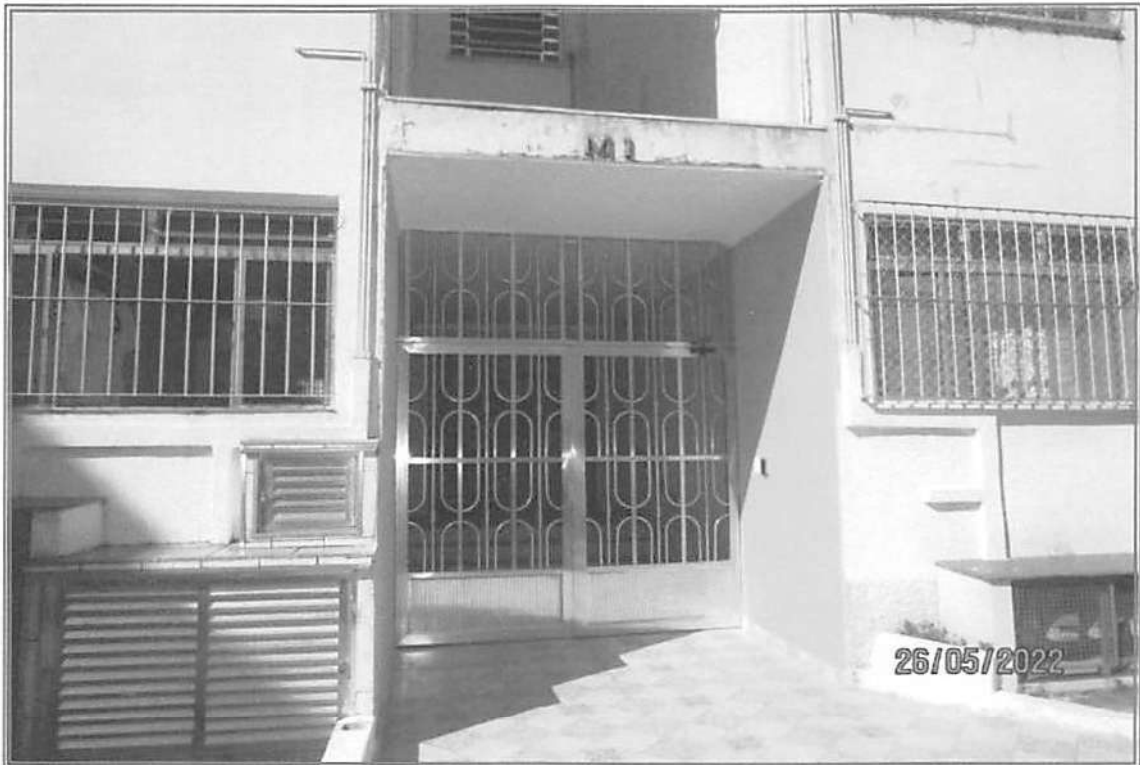
Foto nº 12: Vista geral da entrada do Bloco 01 ou "M1", onde se localiza a unidade avaliando de nº 44.
