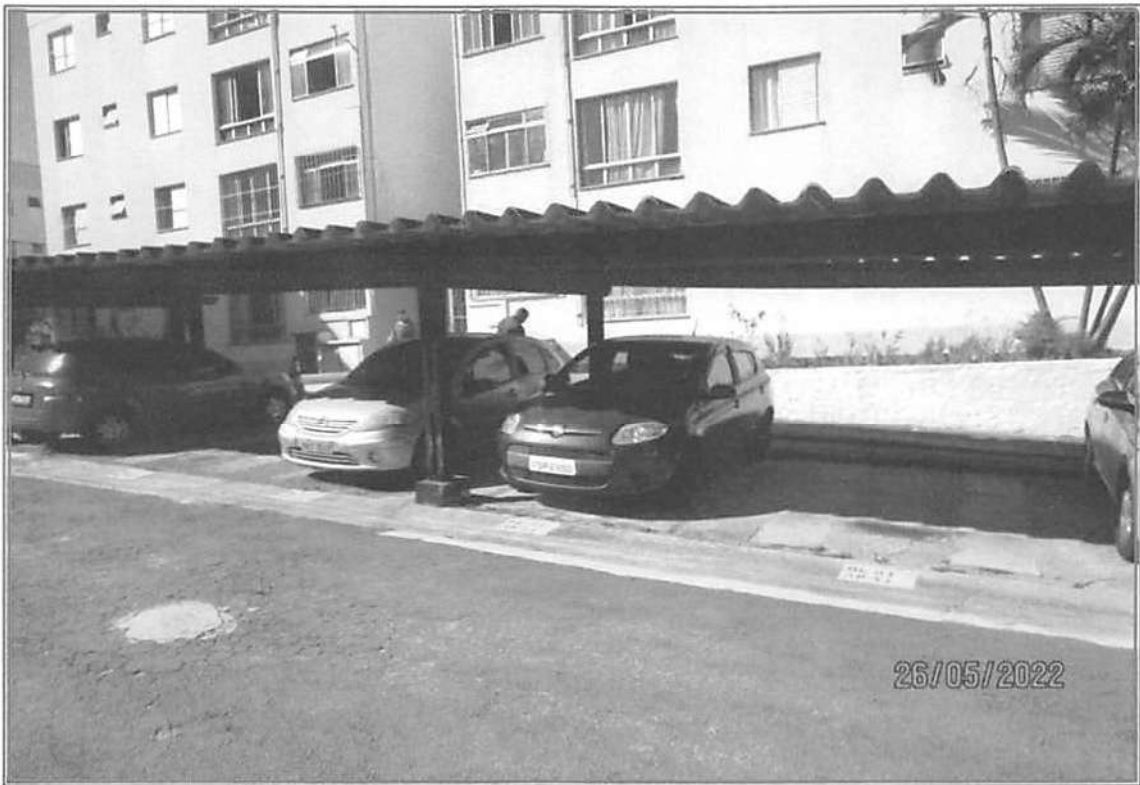
Foto nº 08: Vista geral da vaga de garagem utilizada pela unidade avalianda.
