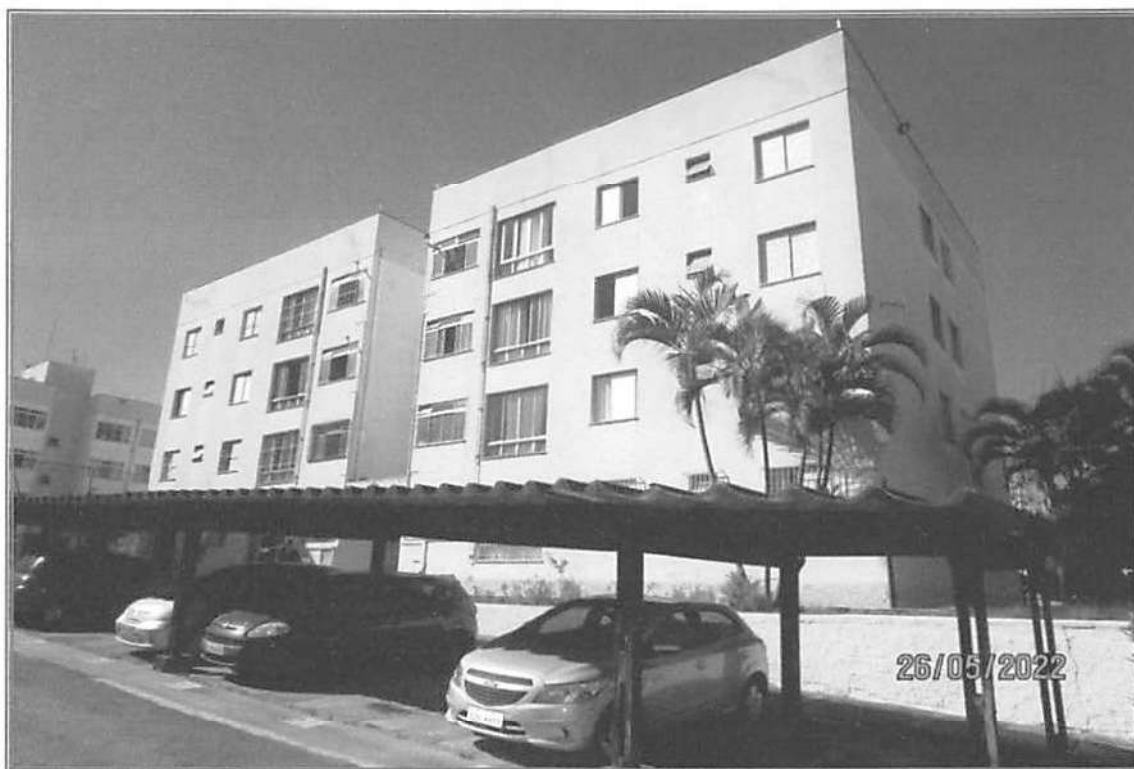
Foto nº 10: Vista geral do Bloco 01 ou M1”, onde se localiza a unidade avaliando de nº 31.
