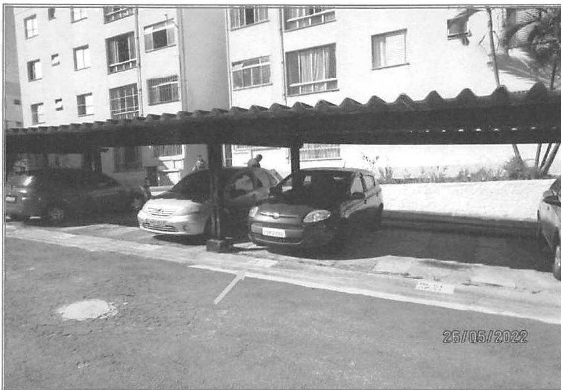
Foto nº 09: Vista geral da vaga de garagem utilizada pela unidade avalianda.
