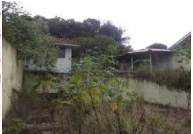
vista interna do imóvel
