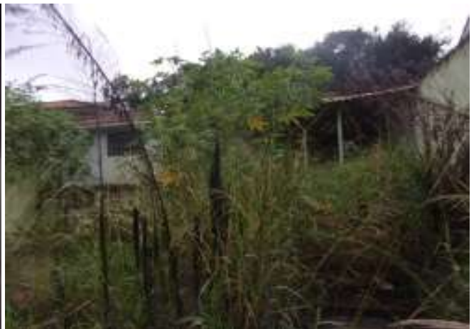
vista interna do imóvel
