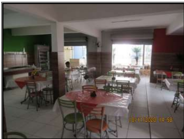
Foto nº 05 Vista parcial da sala do Restaurante Possuindo piso cerâmico; paredes em alvenaria convencional revestidas com cerâmicas; com teto em forro de laje; porta e janela de alumínio com vidro.
