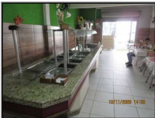
Foto nº 06 Vista da área do Buffet Possuindo piso cerâmico; paredes em alvenaria convencional revestidas com cerâmicas; com teto em forro de laje; porta e janela de alumínio com vidro.
