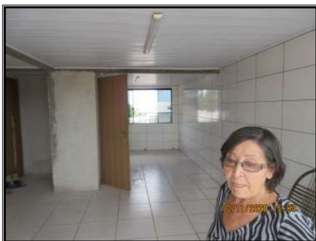
Foto nº 14 Vista parcial da área vazia segundo pavimento
