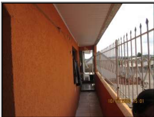
Foto nº 12 Vista parcial da área lateral Possuindo piso cerâmico com grades de proteção
