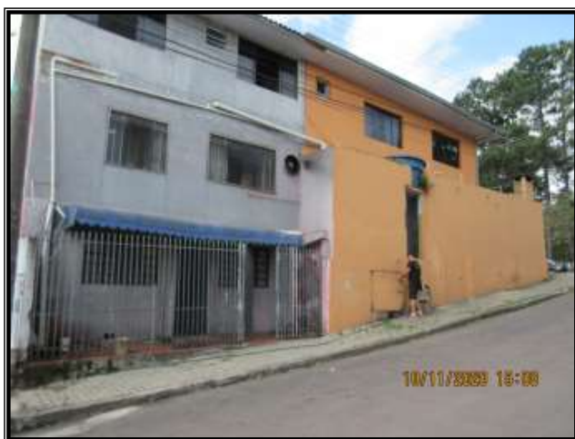
Foto nº 14 Vista parcial da fachada do subsolo
