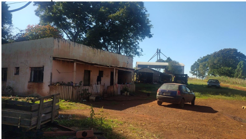
Foto 1 – Vista parcial do imóvel rural com as acessões industriais
