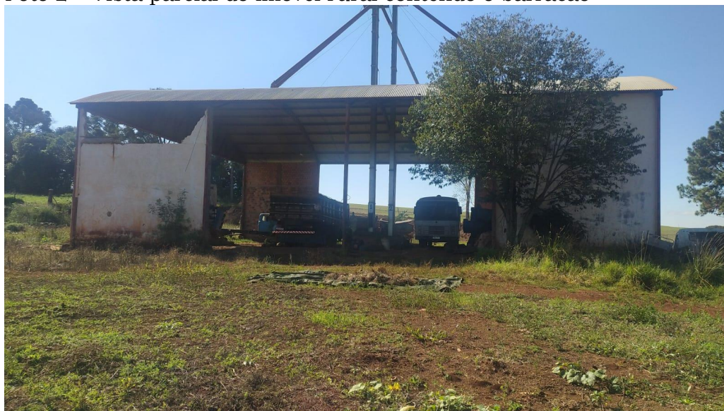
Foto 2 – Vista parcial do imóvel rural contendo o barracão
