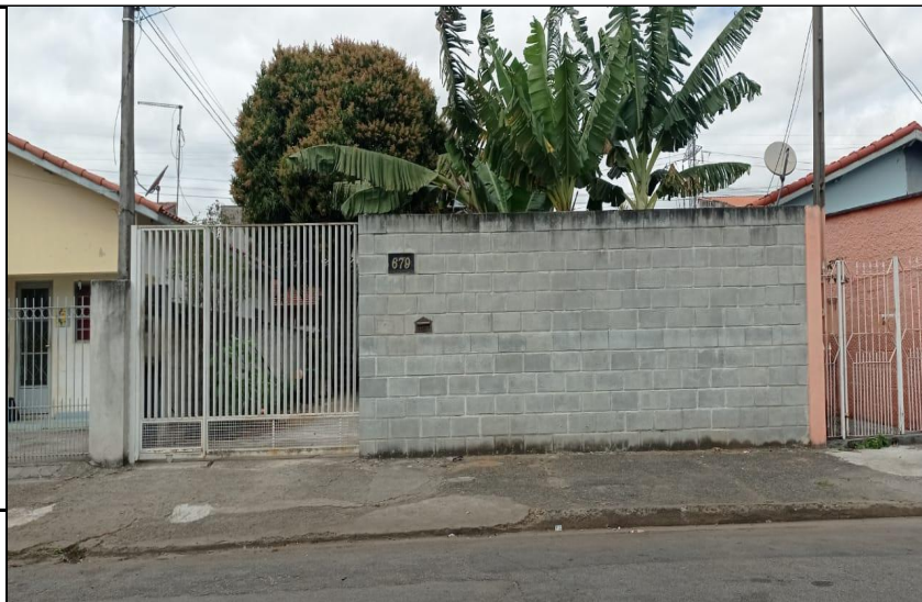
Foto da Fachada do Imóvel
