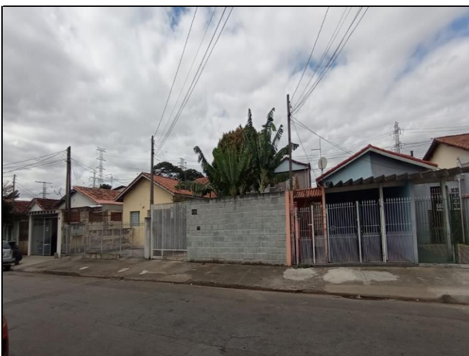
VISTA DA FACHADA DO IMÓVEL EM ESTUDO
