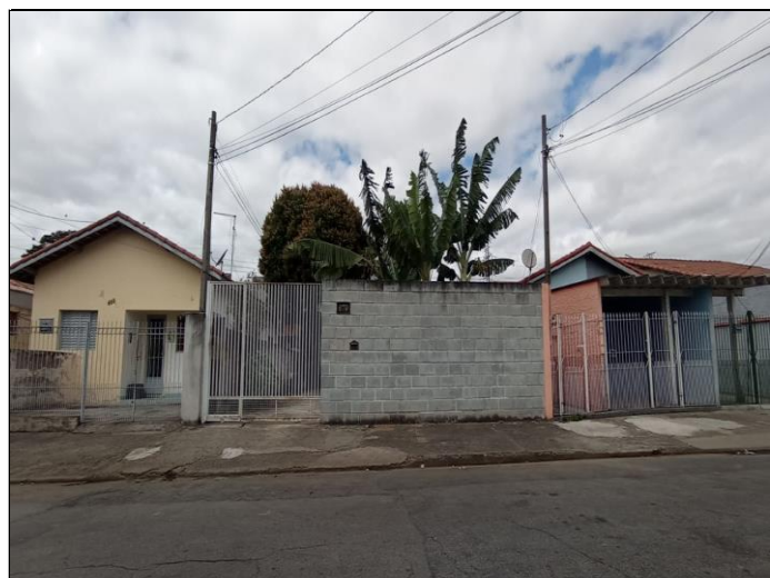
VISTA DA FACHADA DO IMÓVEL EM ESTUDO
