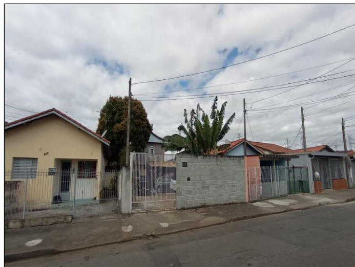
VISTA DA FACHADA DO IMÓVEL EM ESTUDO
