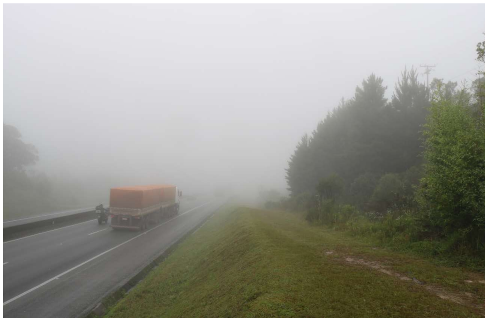
Foto 6 – 14/12/19 – Vista sentido Paranaguá em frente ao portão de acesso do imóvel
