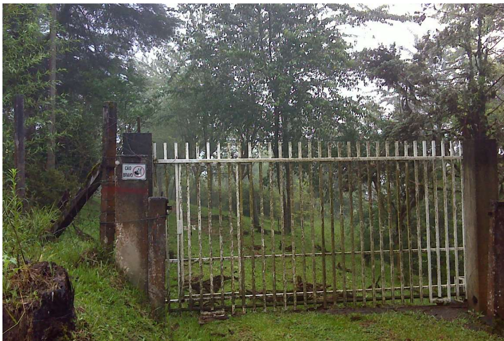
Foto 2 – 14/12/19 - Vista do acesso ao imóvel
