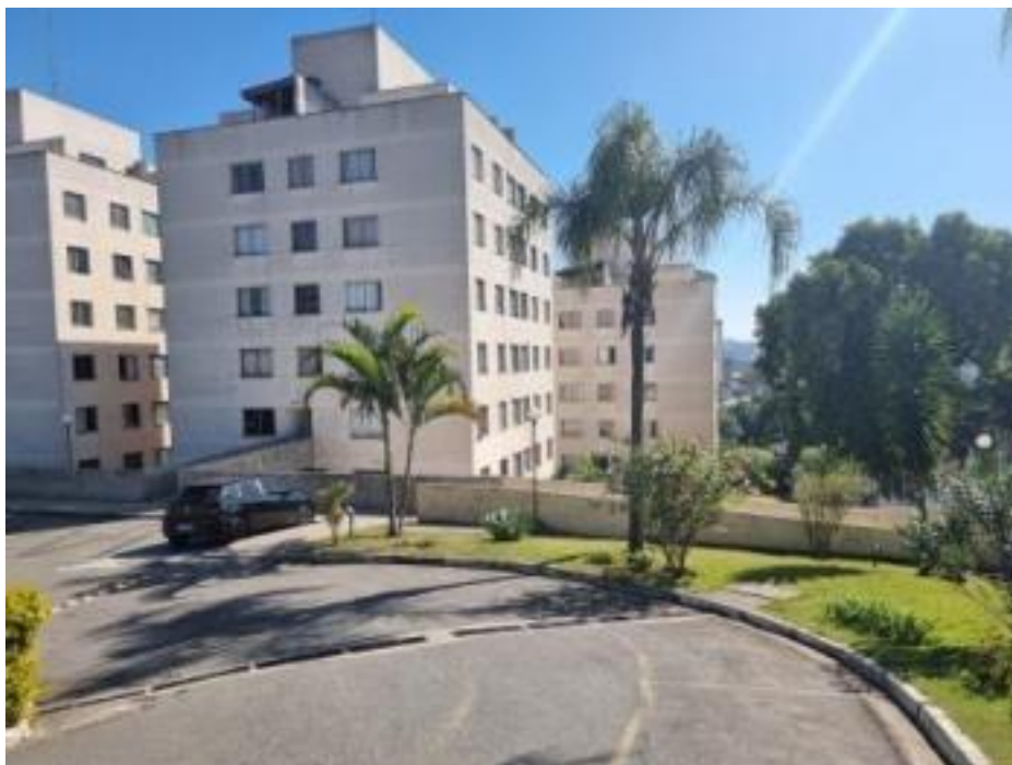
FOTO 3 – ACESSO AS TORRES E ESTACIONAMENTO
