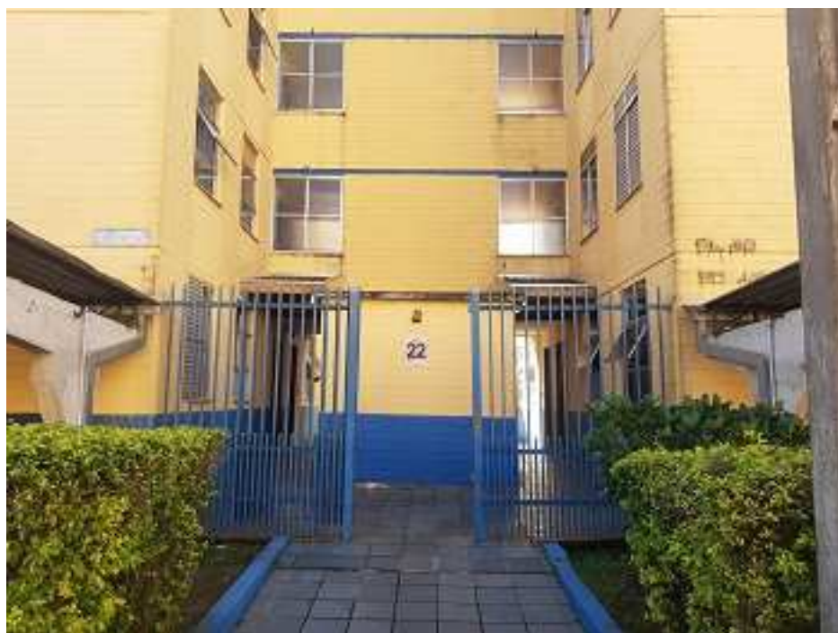
FOTO 19 – VISTA DO BLOCO
