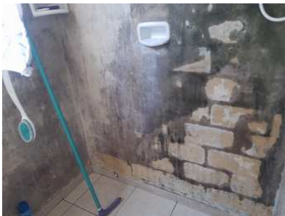
FOTO 09 – BOX DO BANHEIRO
