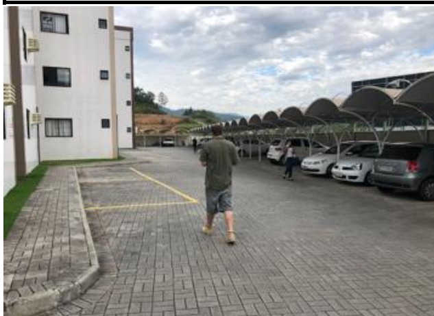
Visão inversa do pátio do estacionamento
