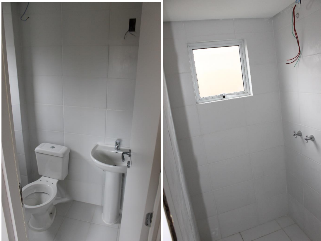
Foto 20 e Foto 21: Banheiro da suíte.
