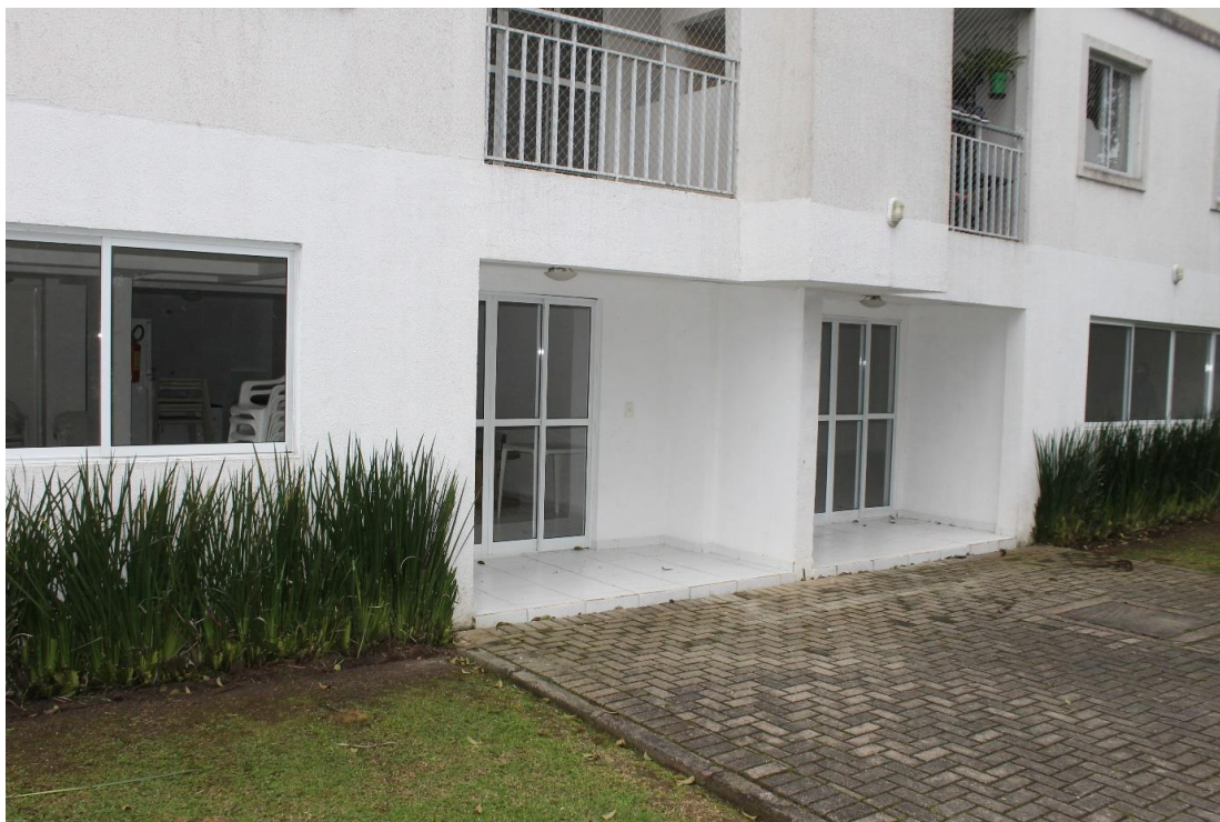
Foto 4: Embaixo do bloco 4 existe a presença de dois salões de festa.
