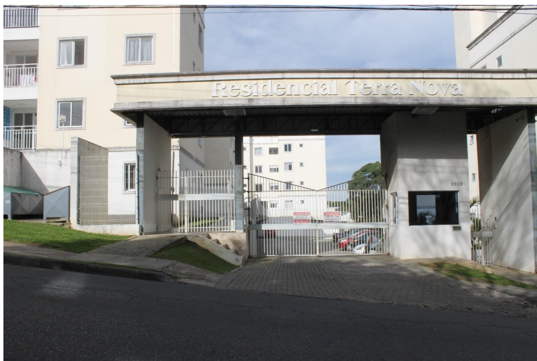
Foto 1: Entrada do condomínio.
