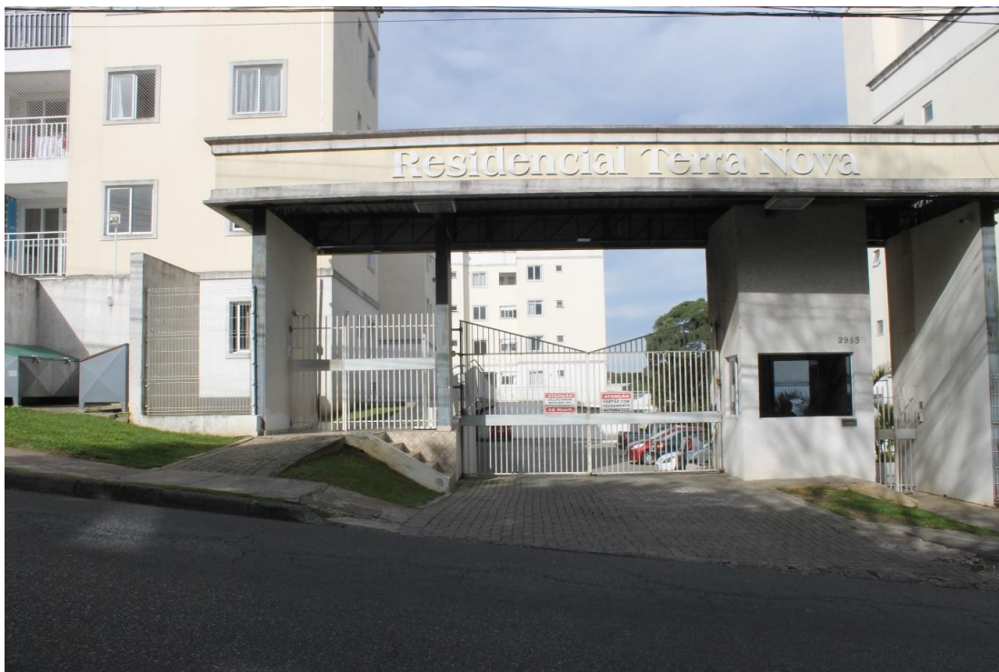
Foto 1: Entrada do condomínio.
