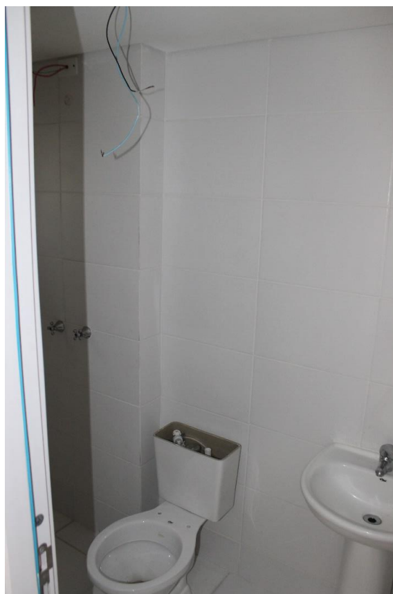
Foto 19: Banheiro da suíte.
