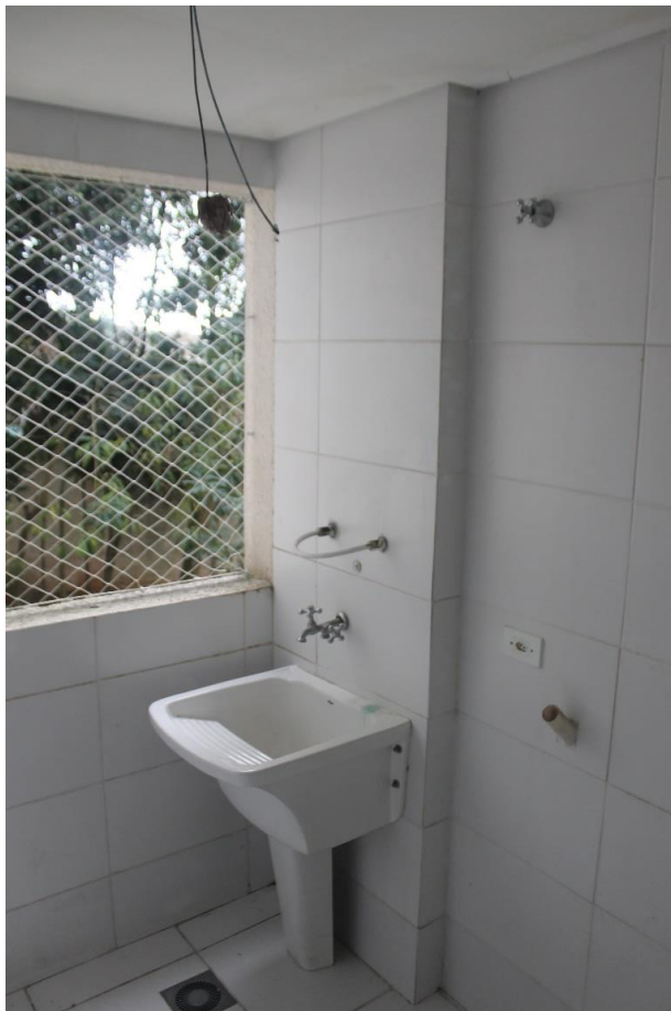
Foto 24: Área de serviço/lavanderia.
