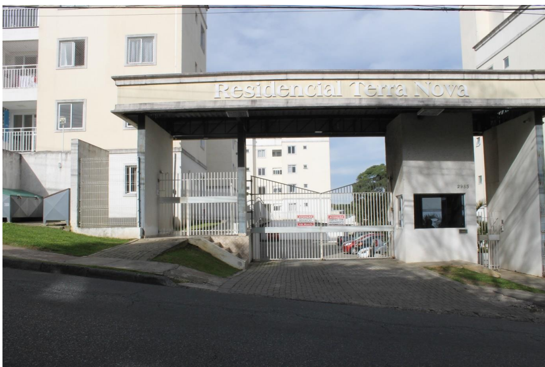
Foto 1: Entrada do condomínio.
