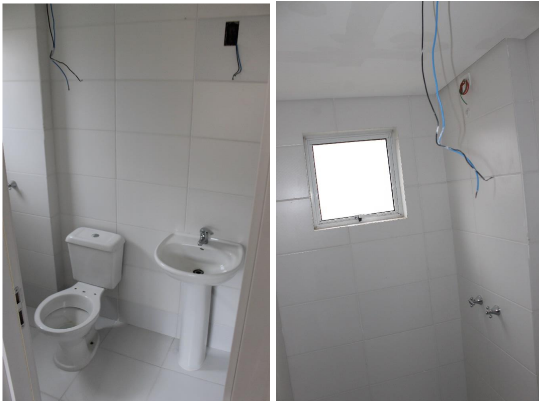
Foto 20 e Foto 21: Banheiro da suíte.
