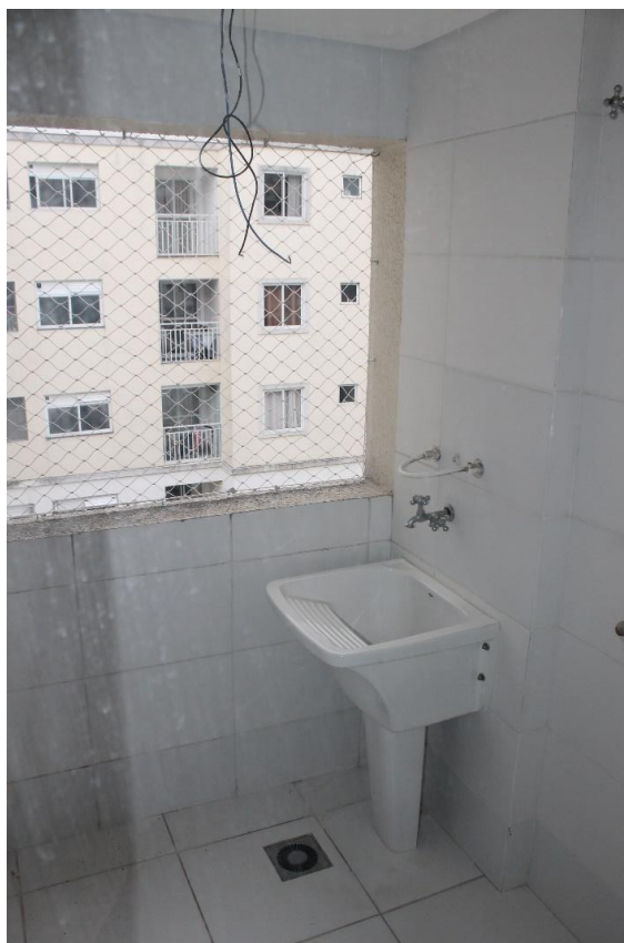
Foto 26: Área de serviço/lavanderia.
