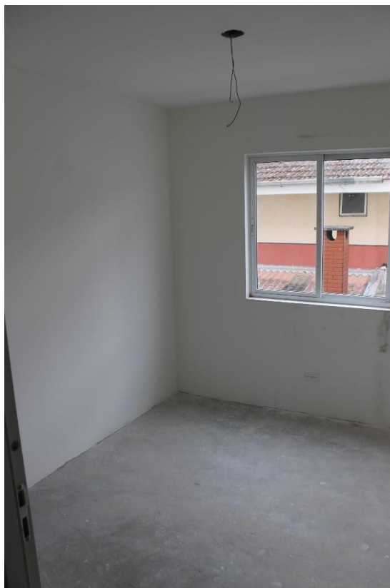
Foto 16: Interior de um dos quartos.
