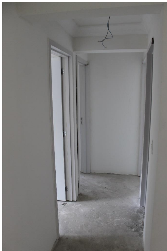
Foto 15: Corredor do apartamento.
