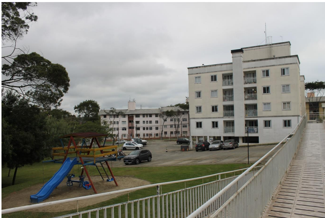
Foto 8: Área comum do condomínio.
