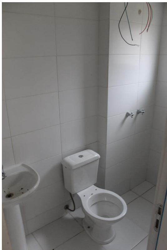
Foto 20: Banheiro da suíte.
