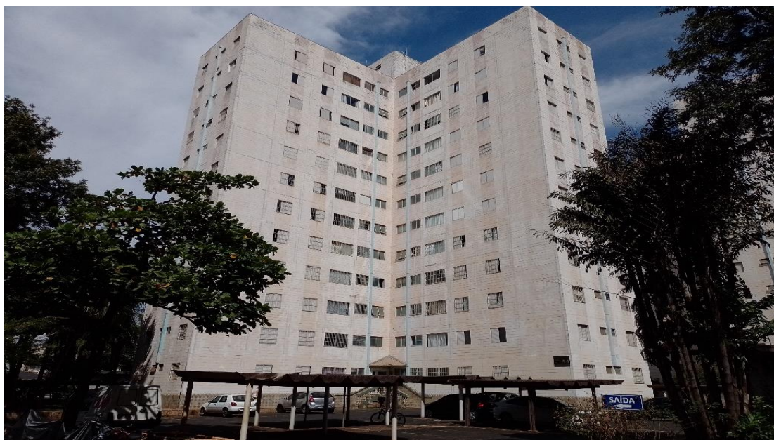
Foto 04: Vista externa do imóvel
