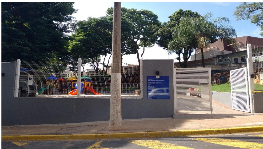
Foto 05: Vista externa do imóvel
