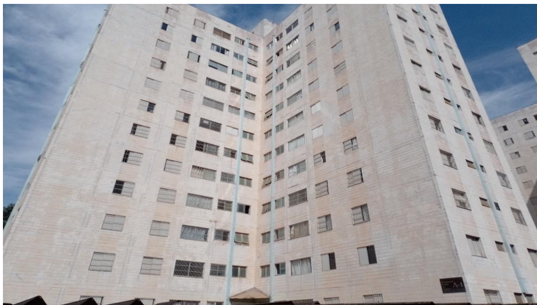
Foto 06: Vista externa do imóvel
