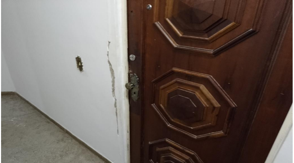
Foto 19: Vista externa porta de acesso ao apartamento
