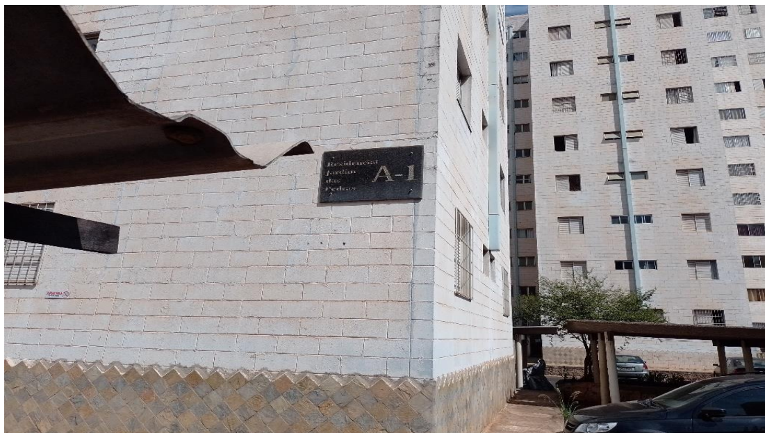
Foto 03: Vista Externa do imóvel.
