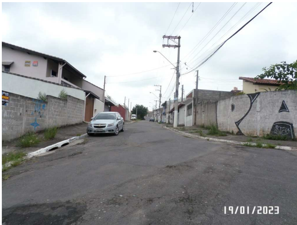
FOTO N º 01 – VISTA DE ACESSO A VIA PÚBLICA – RUA GIANCARLO MANETTI.
